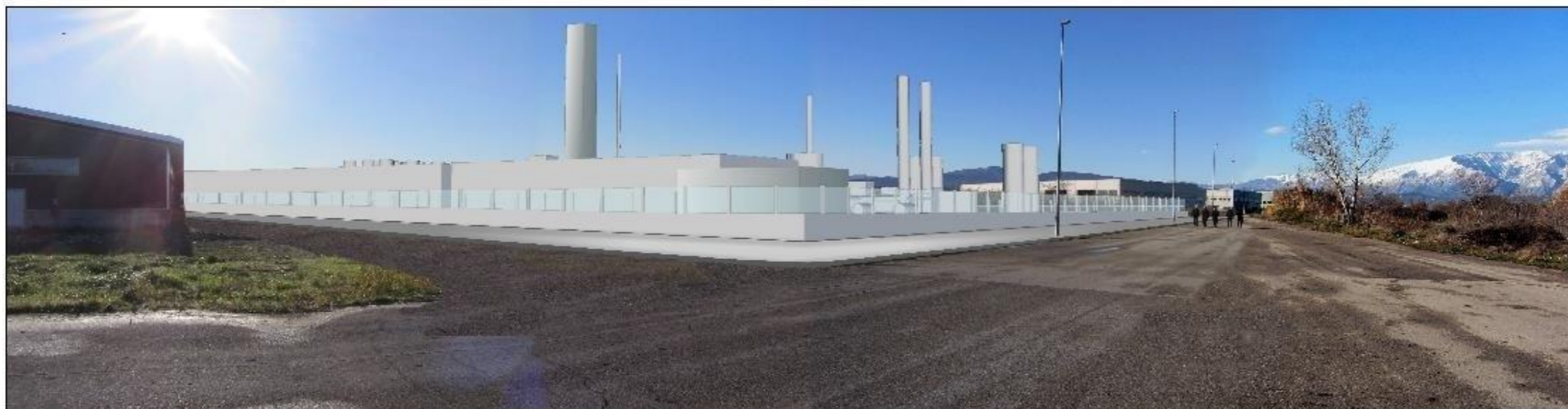
Fotosimulazione 01 La Centrale di trattamento di Paglieta a fine lavori (cfr. Documentazione fotografica scatto n°73).
