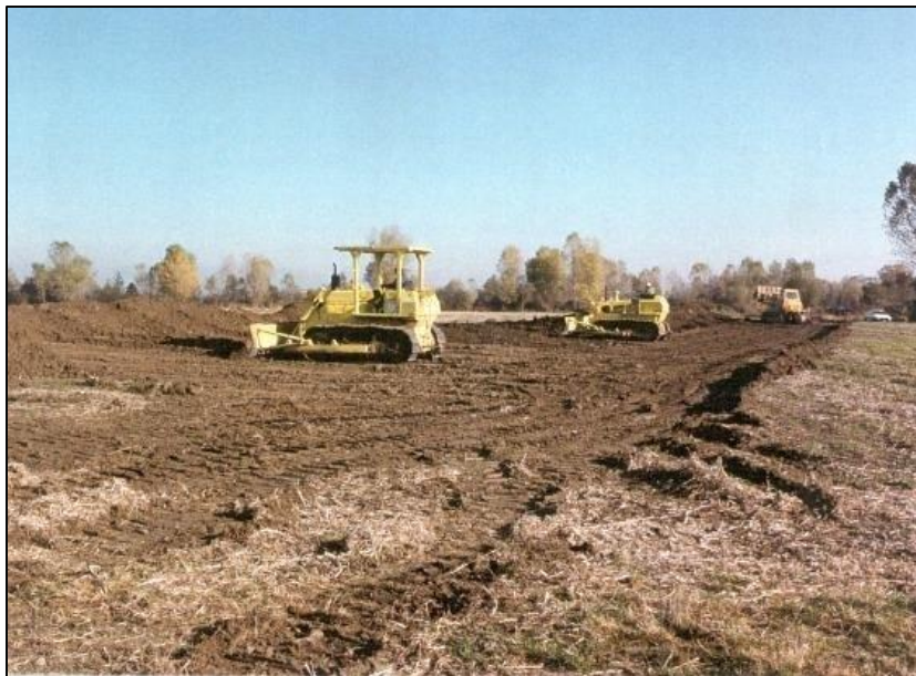
Foto 3.2.20 – Apertura della fascia di lavoro
