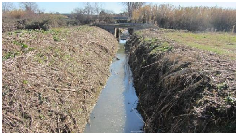
Foto 3.2.15 - Piana Signorelle: sezione del fosso - canale attraversato dal gasdotto
