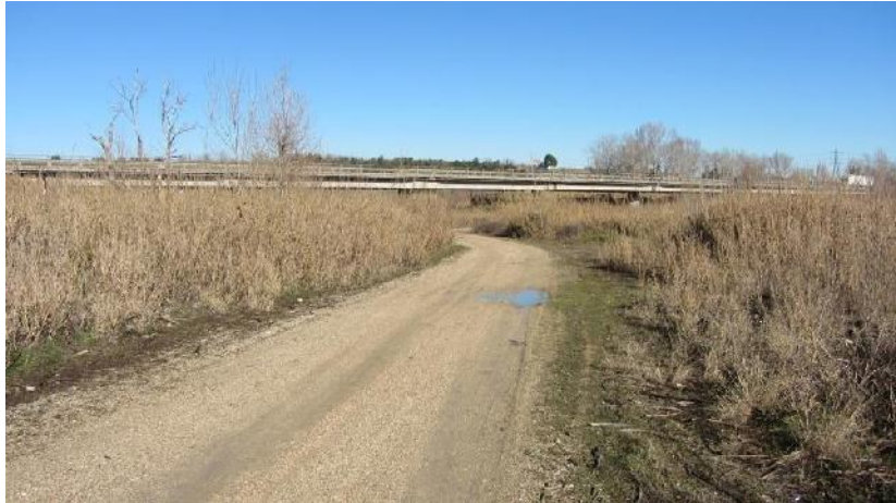
Foto 3.2.17 - V 111 in prossimità SIC IT7140112; viadotto Fondovalle Sangro
