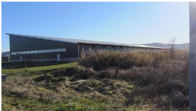
Foto 3.3.2 – Il capannone industriale contiguo alla futura Centrale Gas
