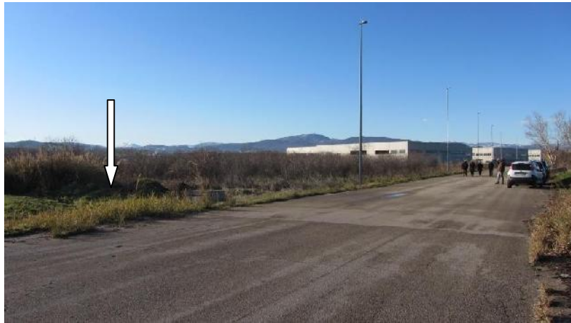
Foto 3.3.1 - Sedime Centrale Trattamento Gas (freccia)
