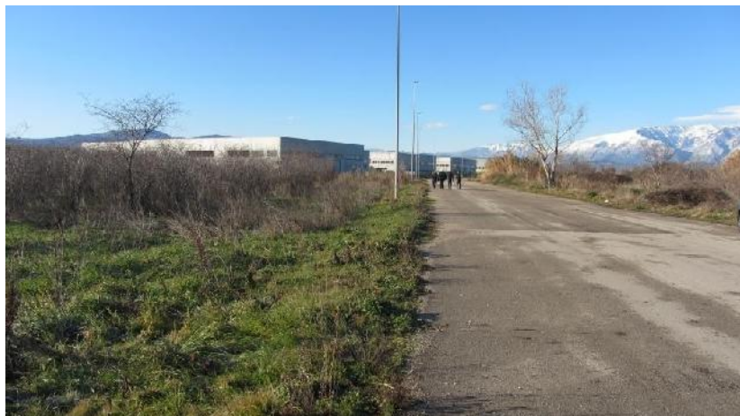
Foto 3.2.18 - V 121- Fine. A sx sedimi della Centrale di Trattamento Gas
