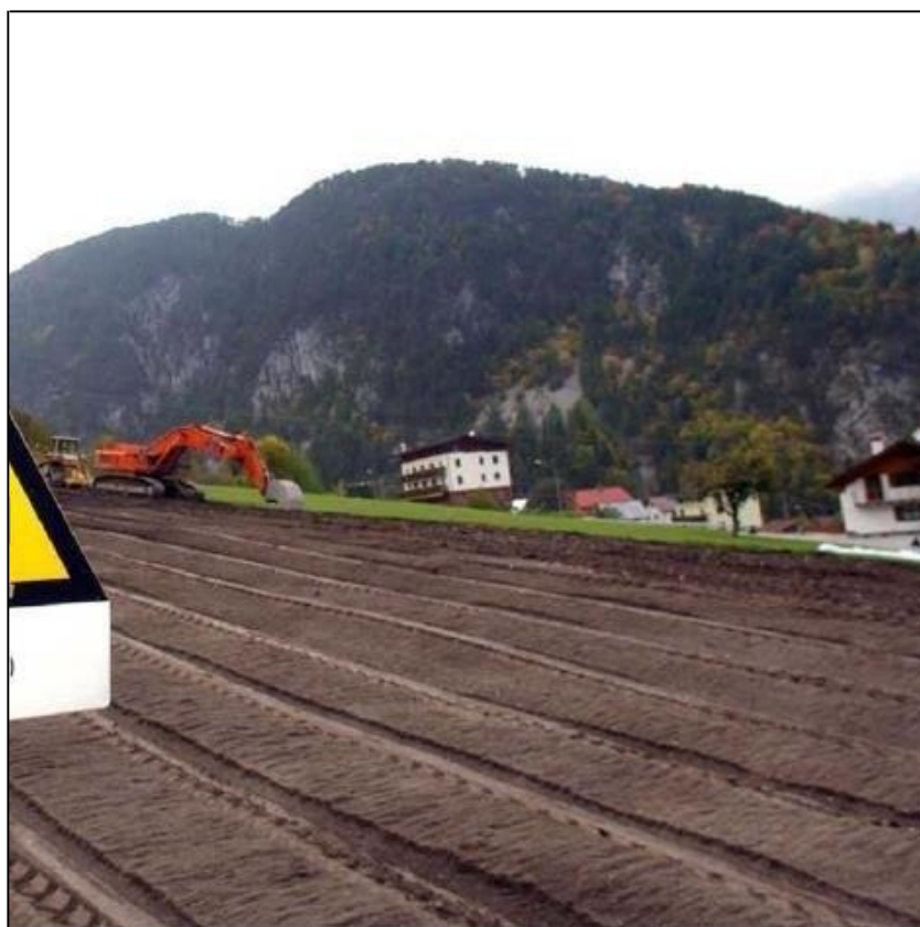
Foto 3.2.24 – Redistribuzione dello strato di suolo fertile superficiale
