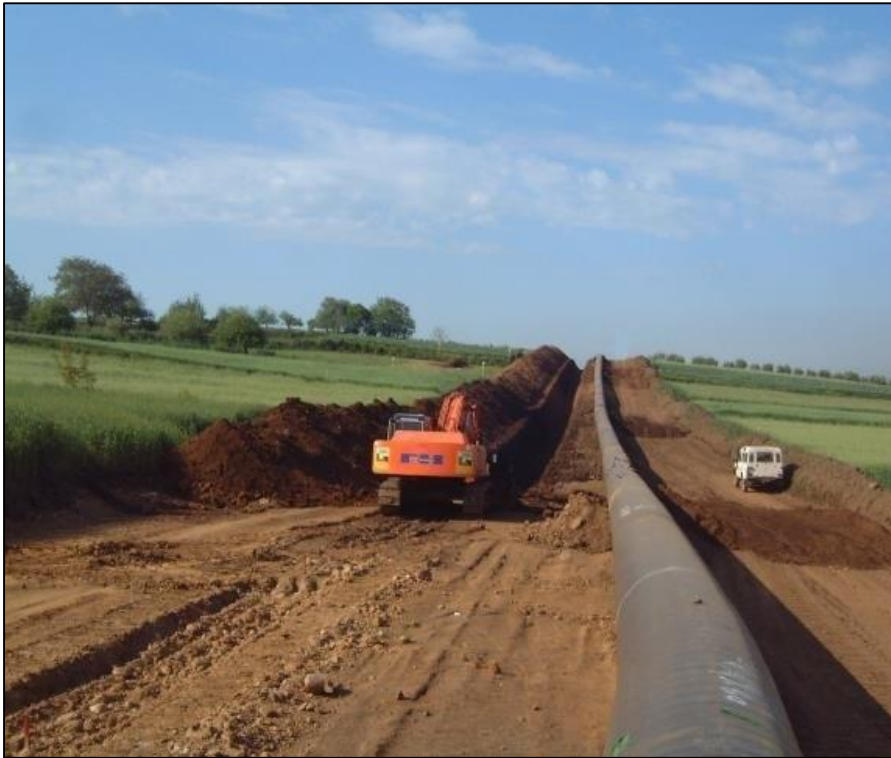
Foto 3.2.22 – Scavo della trincea
