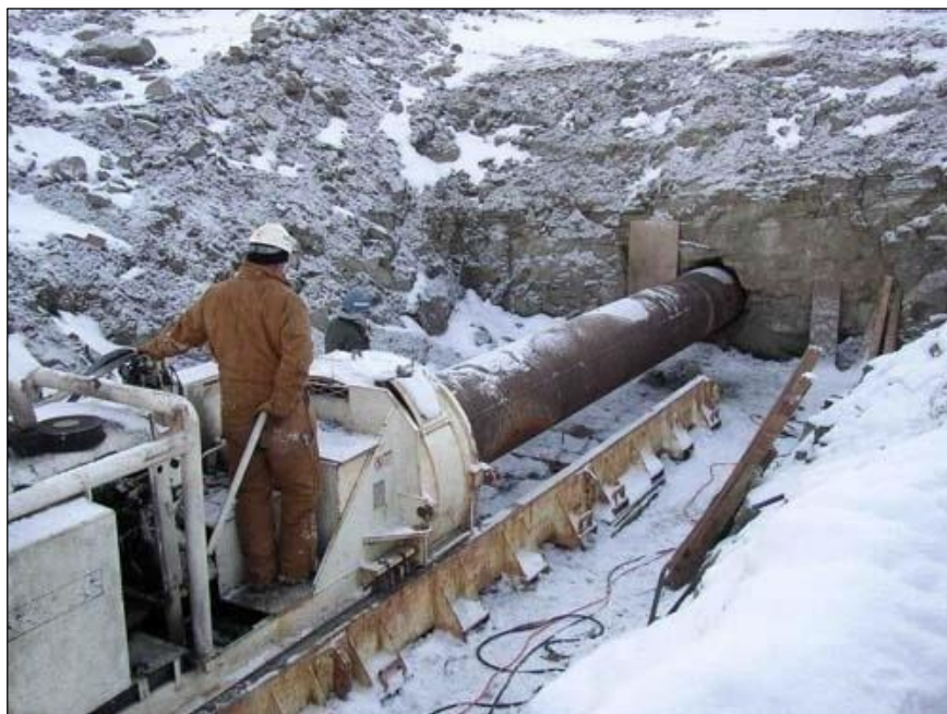
Foto 3.2.25 – Attraversamento mediante presso trivella (Spingitubo)
