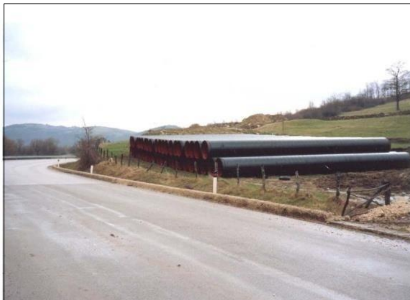
Foto 3.2.29 – Tipologico piazzola accatastamento (in foto tubazioni di grande sezione)
