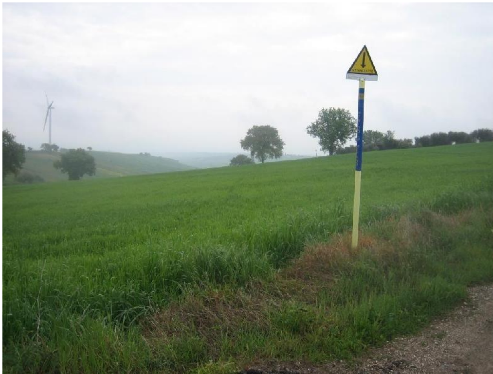
Foto 5.1.1.. – Tipologico "palina di segnalazione" gasdotto
