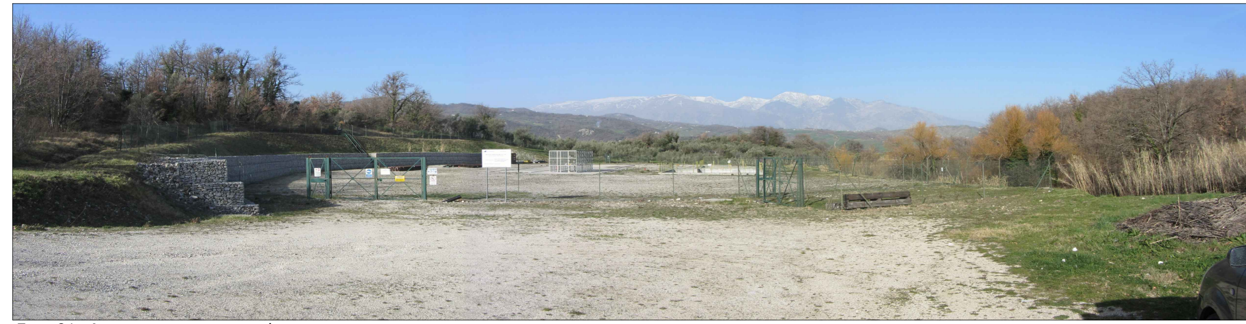
Foto 01: Area pozzo stato attuale
