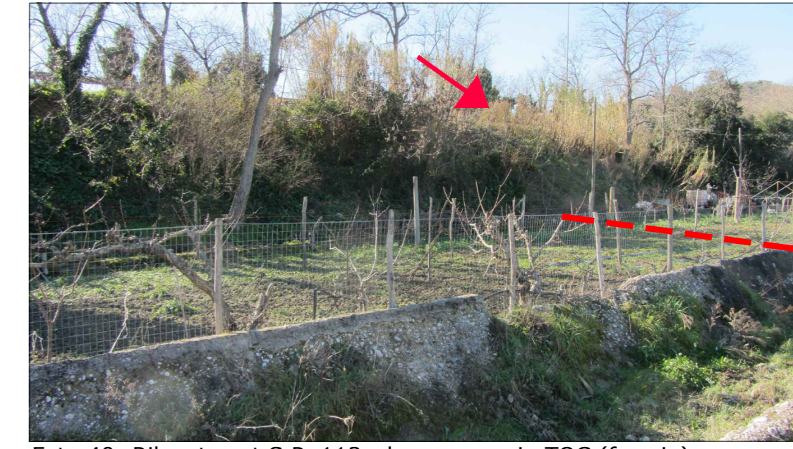
Foto 40: Rilevato est S.P. 113: da superare in TOC (freccia)
