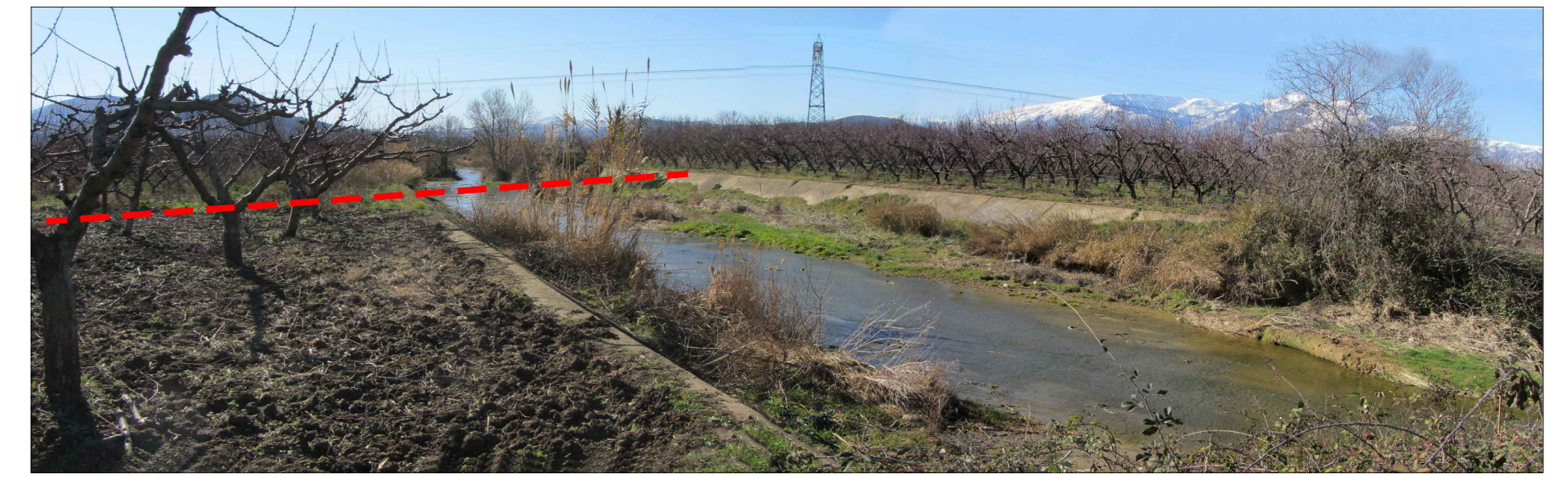
Foto 51: Sottopasso del fosso canalizzato in Loc. Le Scosse
