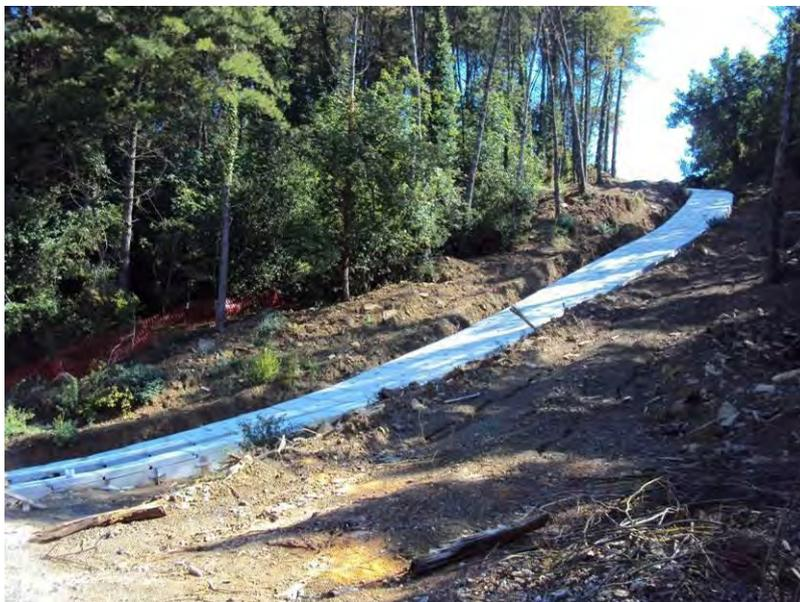
**Realizzazione di elettrodotto in cavo interrato a in area boscata con eliminazione completa e permanente del soprassuolo vegetale e boschivo**
