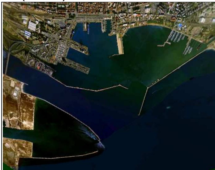
Figura 2-4 Foto aerea del bacino portuale di Cagliari 1
