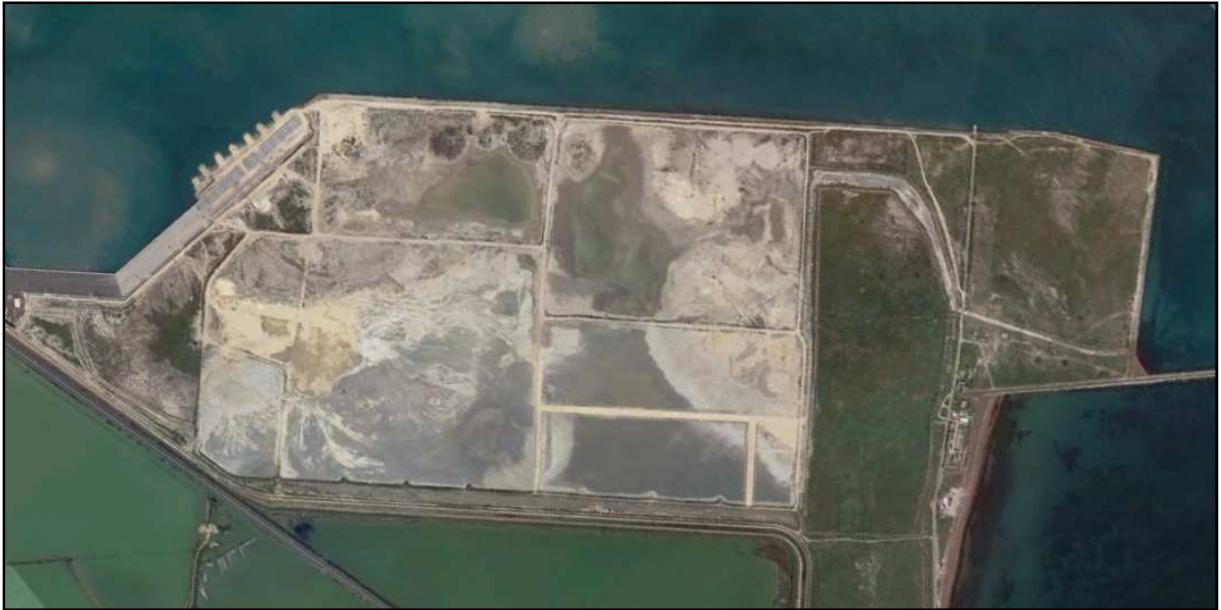
Figura 6-1 – Casse di colmata esistenti
