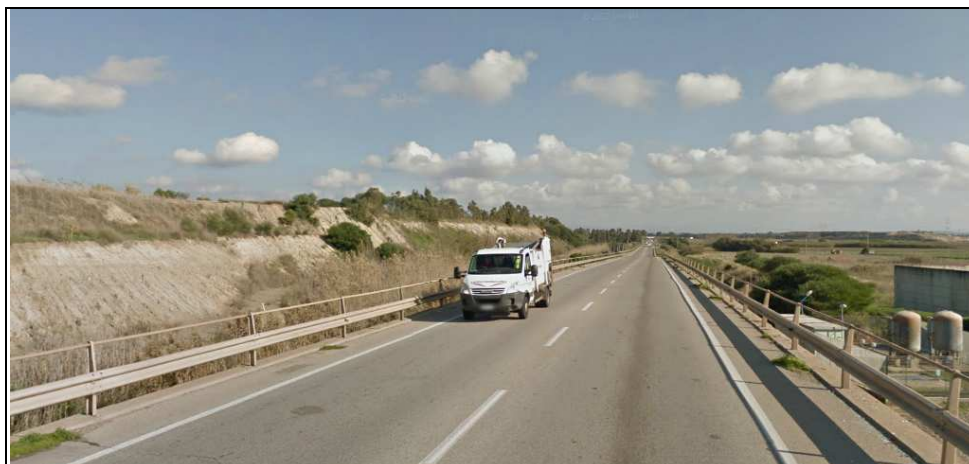
Figura 3-15: viabilità ad una corsia per senso di marcia con banchine - punto 4 di mappa della Figura 3-10
