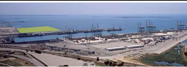
**INTERVENTI PER IL DRAGAGGIO DI 2,3 M<sup>3</sup> DI SEDIMENTI IN AREA MOLO POLISSETORIALE PER LA REALIZZAZIONE DI UN PRIMO LOTTO DELLA CASSA DI COLMATA FUNZIONALE ALL'AMPLIAMENTO DEL V SPORGENTE DEL PORTO DI TARANTO**
