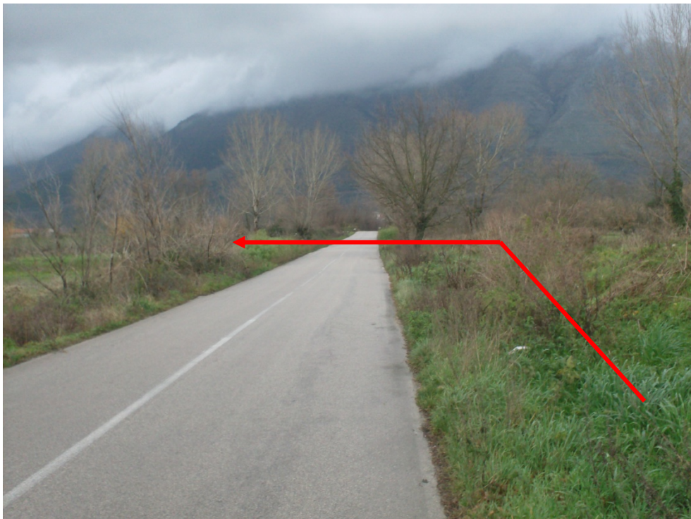
Foto 11 - Attraversamento S.P. n. 83
