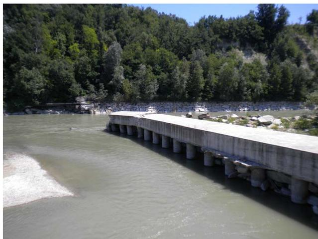
Figura 2. Particolare della traversa crollata
