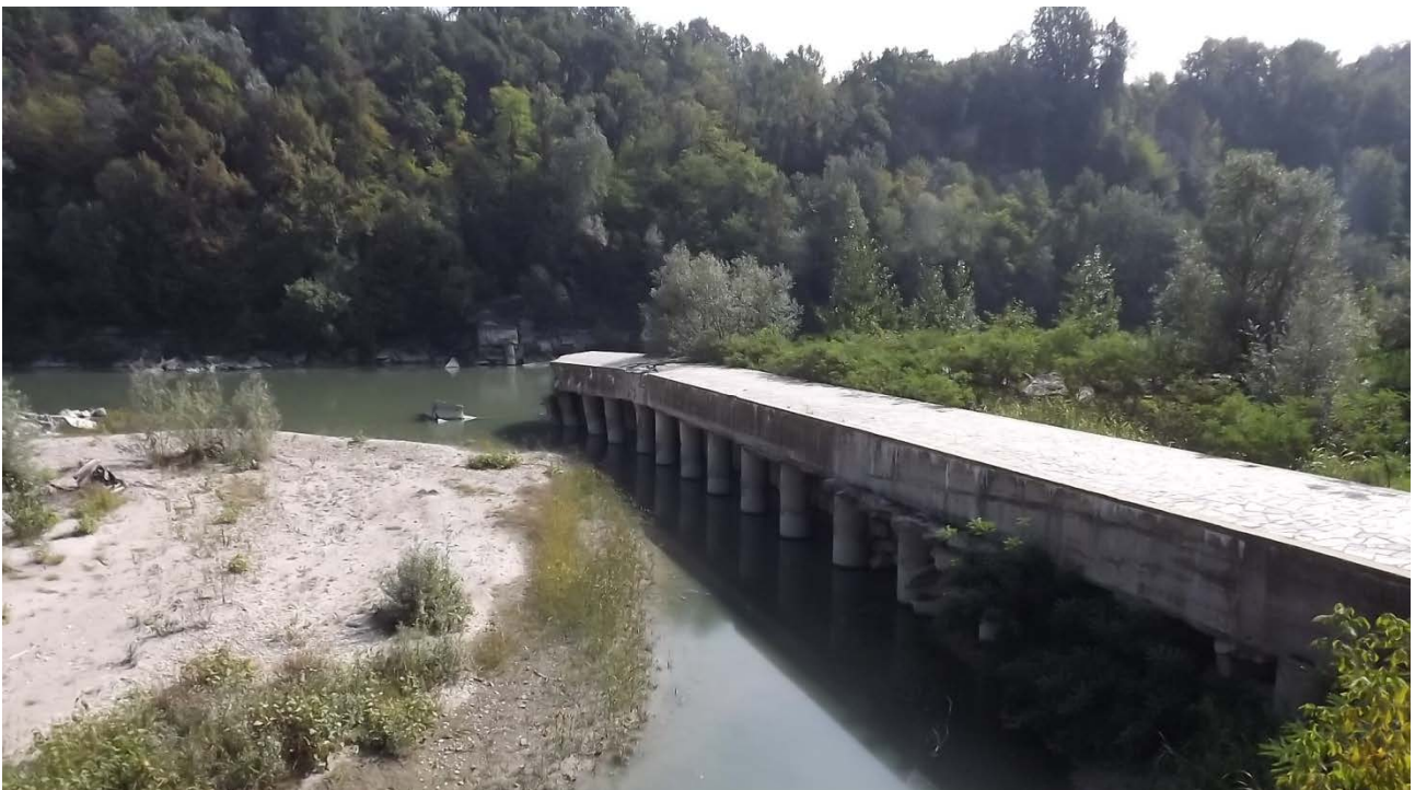
Fig. 9. La traversa parzialmente distrutta come si presenta attualmente. Vista da W-NW.
