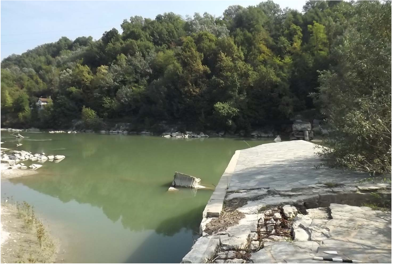
Fig. 6. Sponda destra del fiume Tanaro in corrispondenza dei resti della traversa esistente. Vista da W.
