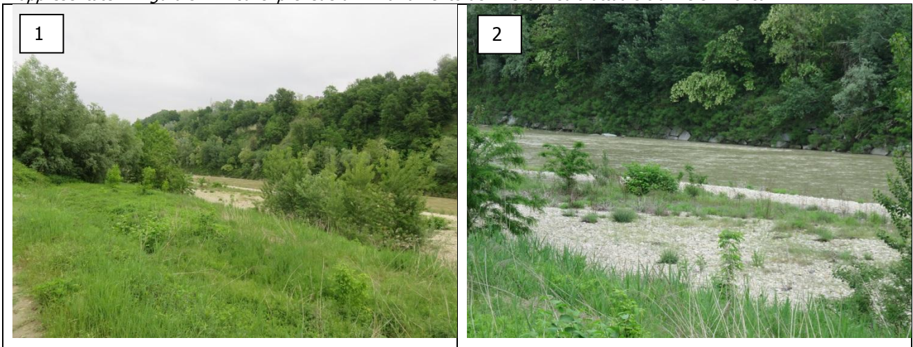
Figura 5.3: documentazione fotografica commentata del tratto a monte della traversa tra le sezioni 140 e 150 rappresentate in Figura 5.1 in cui si prevede un innalzamento del livello medio attuale tra 2 e 3 m circa
