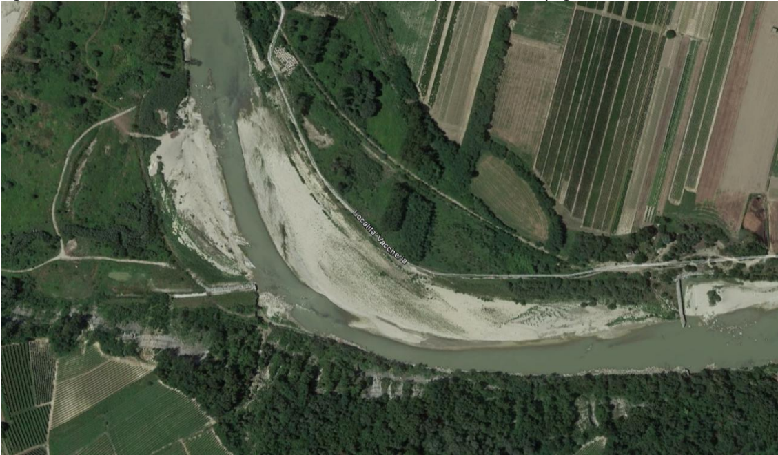
Figura 5.6: area a monte della traversa in cui è evidente la presenza di ampi greti.
