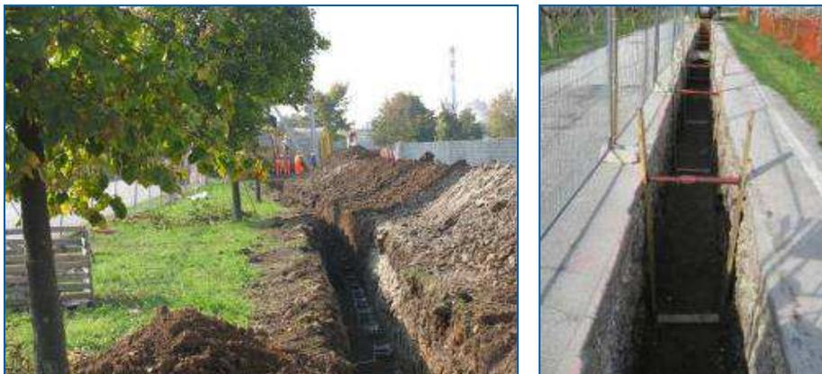
Figura 15: Esempio di realizzazione di trincee di scavo per la posa dei cavi interrati e il deposito temporaneo del materiale da scavo.
