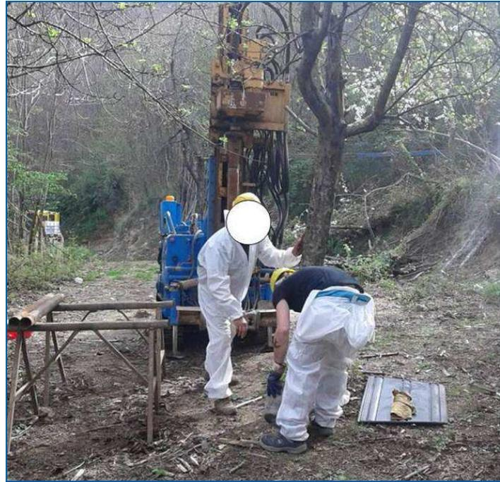
Figura 3: Sondaggio effettuato mediante perforazione a carotaggio.
