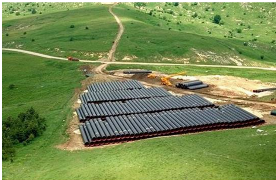
Fig. 5.1/A – Foto tipica di una piazzola per accatastamento tubazioni
