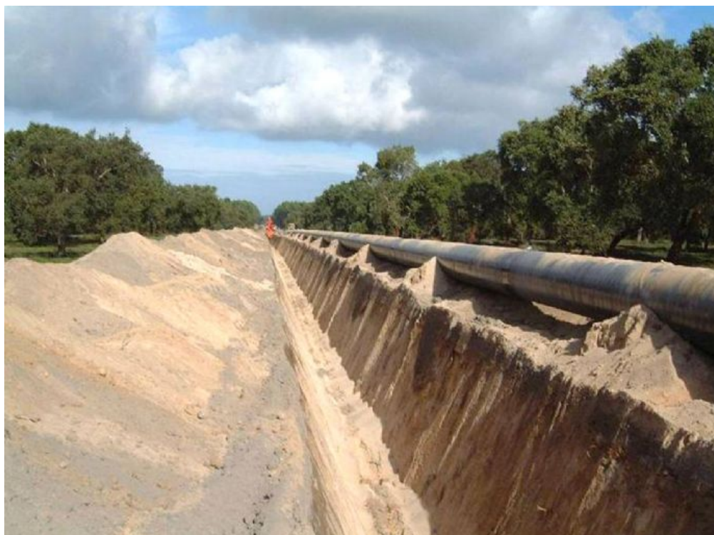
Fig. 5.3/A – Foto tipica di scavo della trincea
