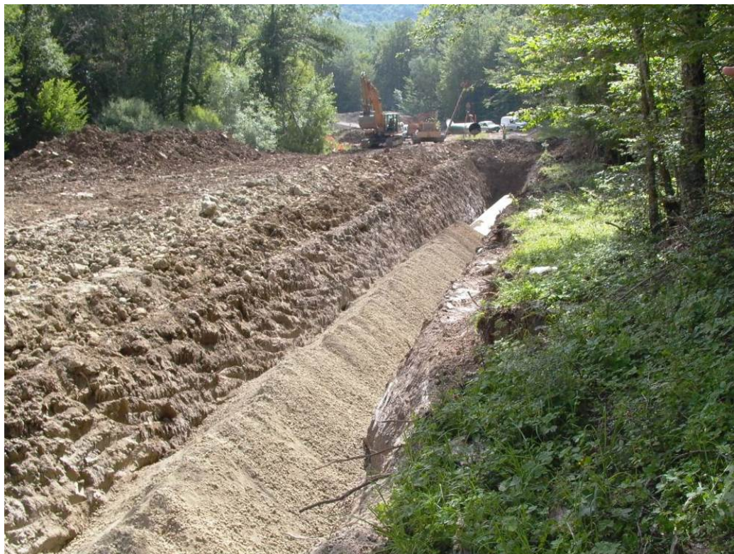
Fig. 5.4/A – Foto tipica di rinterro della condotta
