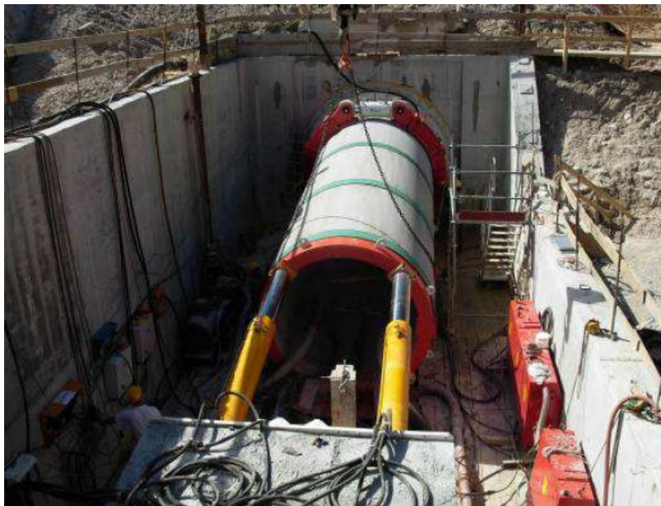
Fig. 5.5/A – “Buca di spinta” del microtunnel
