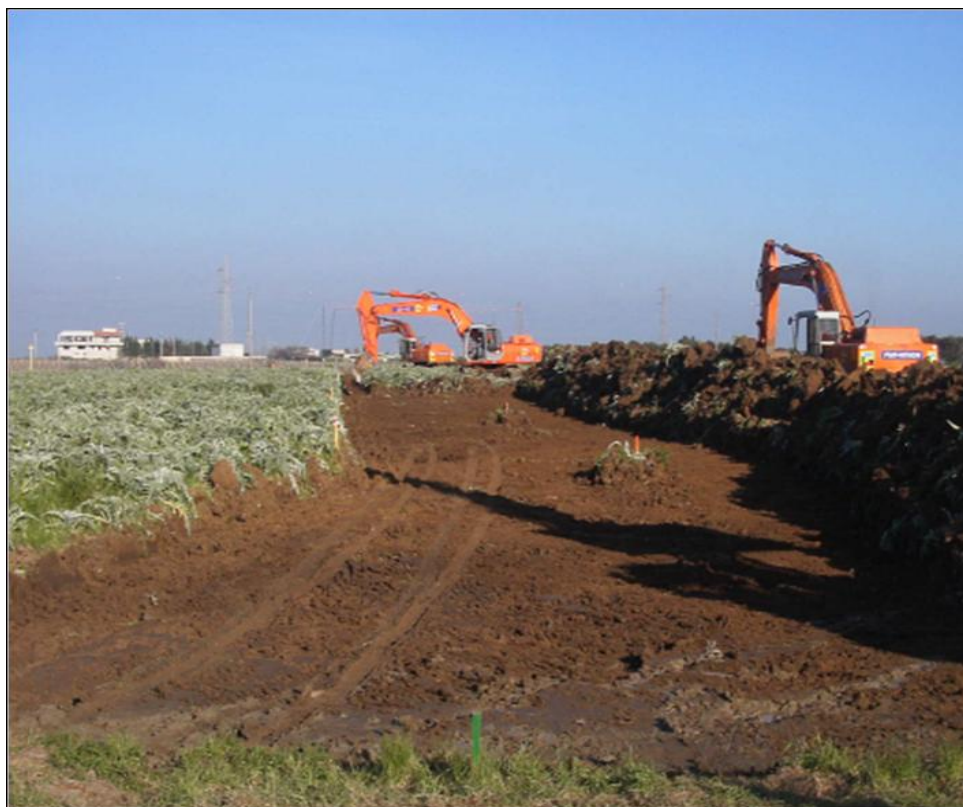
Fig. 5.2/A – Foto di apertura dell'area di passaggio
