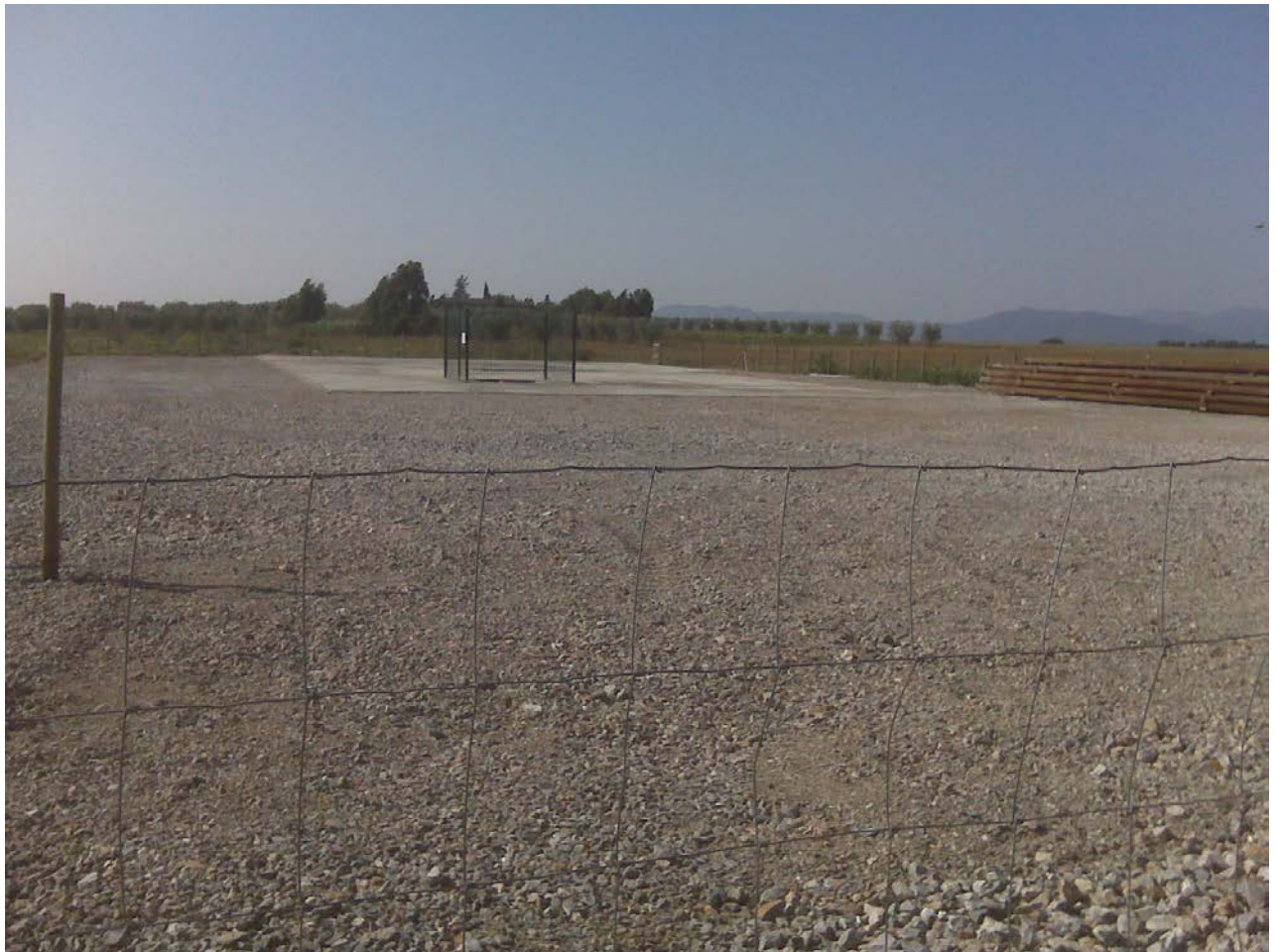
Fig. 1-B Postazione allo stato nudo, senza RIG (ottobre 2010)
