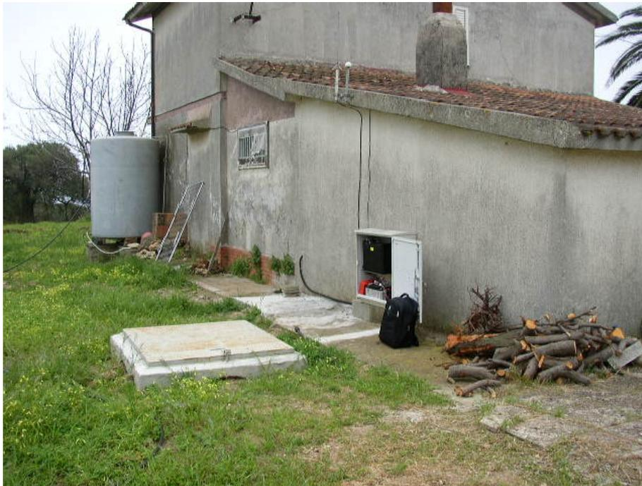
**Fig. 35: armadietto con la strumentazione installato sul retro di un garage e pozzetto del sensore.**
