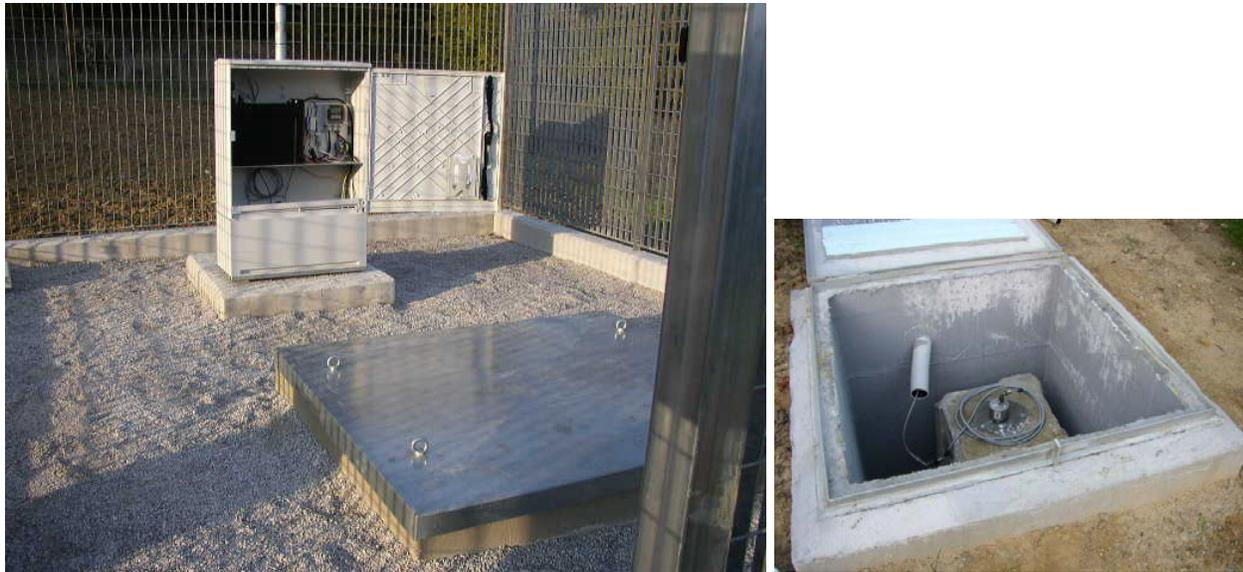
**Fig. 33:** esempio di alloggiamento della strumentazione nell'armadietto e del sensore all'interno del pozzetto.
