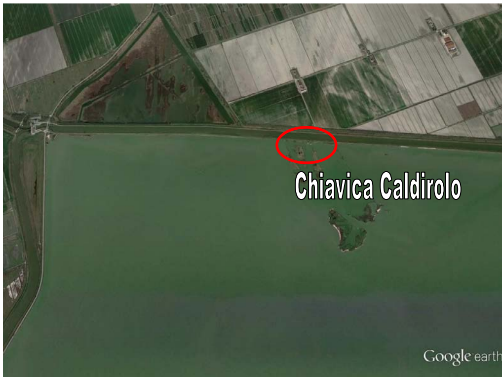
Figura 2-6 Sistema Valli di Comacchio. Particolare Zona Nord di Valle Fossa di Porto con Chiavica Caldirolo.
