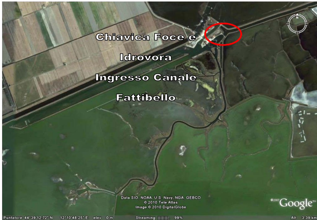
Figura 2-5. Sistema Valli di Comacchio. Particolare Zona Nord –Est di Valle Cona con Chiavica su Canale Foce – Valle Fattibello.
