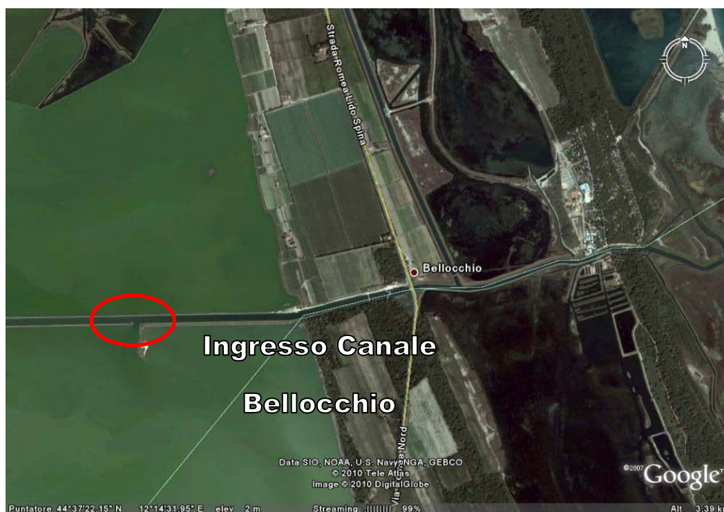
Figura 2-7 . Sistema Valli di Comacchio. Particolare Zona Est con Chiavica su Canale Bellocchio.
