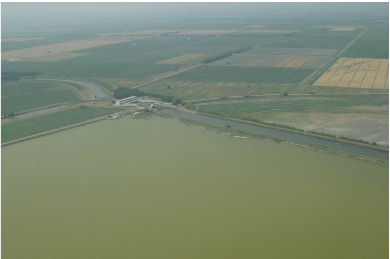
Margine NW delle Valli, argine Agosta, casone e idrovora Fosse: ben evidente lo stato di ipertrofia delle acque vallive (acque verdi) rispetto alla acque del Canale Fosse Foce (acque blu). (Foto: Volo 2003)
