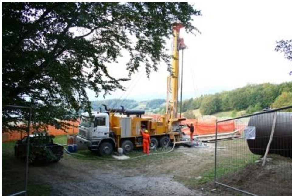
Figura 4 – Tipologia di cantiere simile a quella prevista per la realizzazione dei pozzi in progetto (Cantiere di perforazione del pozzo n. 7 della Concessione Mineraria n. 704 denominata Barigazzo, posta circa a 5 chilometri più ad est rispetto la Concessione Vetta).
