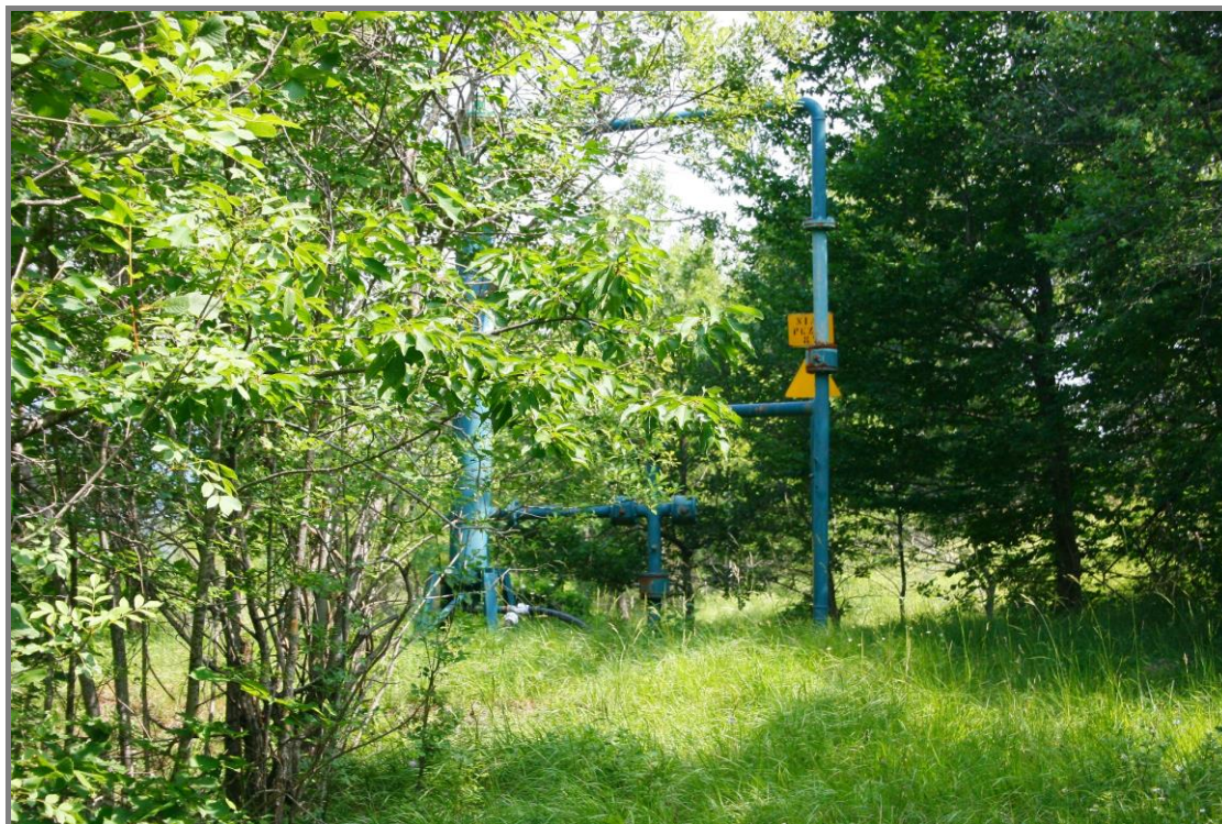
Figura 1 – Pozzo SIAM Vetta n. 8V – L'altezza massima dell'apparato (in verde) è pari a circa 2-2.5 m.
