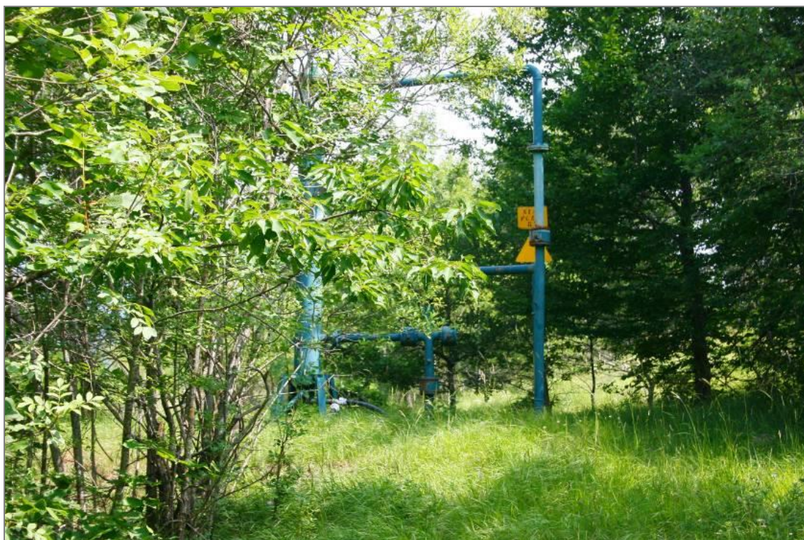
Figura 8 – Pozzo SIAM. Le ridotte dimensioni dell'area occupata, nonché le forme allungate e l'uso dei colori appropriati, consentono di mimetizzare il manufatto che, già a breve distanza, tende a confondersi con la vegetazione spontanea.
