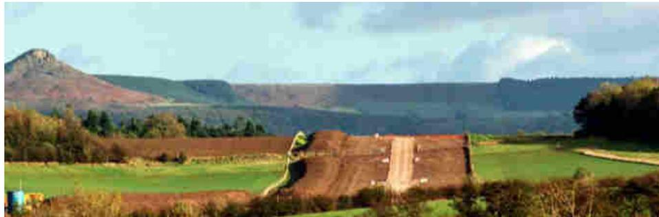
Va tuttavia evidenziato che una posa come quella riportata in figura va assolutamente evitata in quanto un guasto lungo il tracciato può determinare anche la disalimentazione della terna adiacente per le attività di riparazione.
