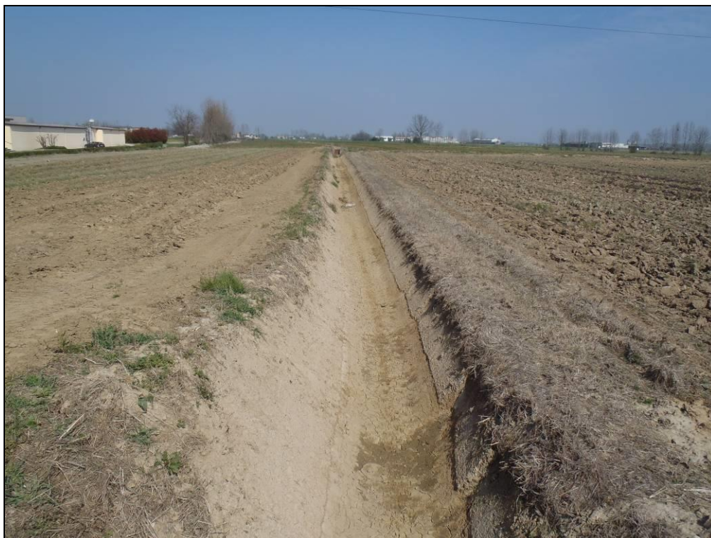
Campo nei pressi del sostegno 173.
