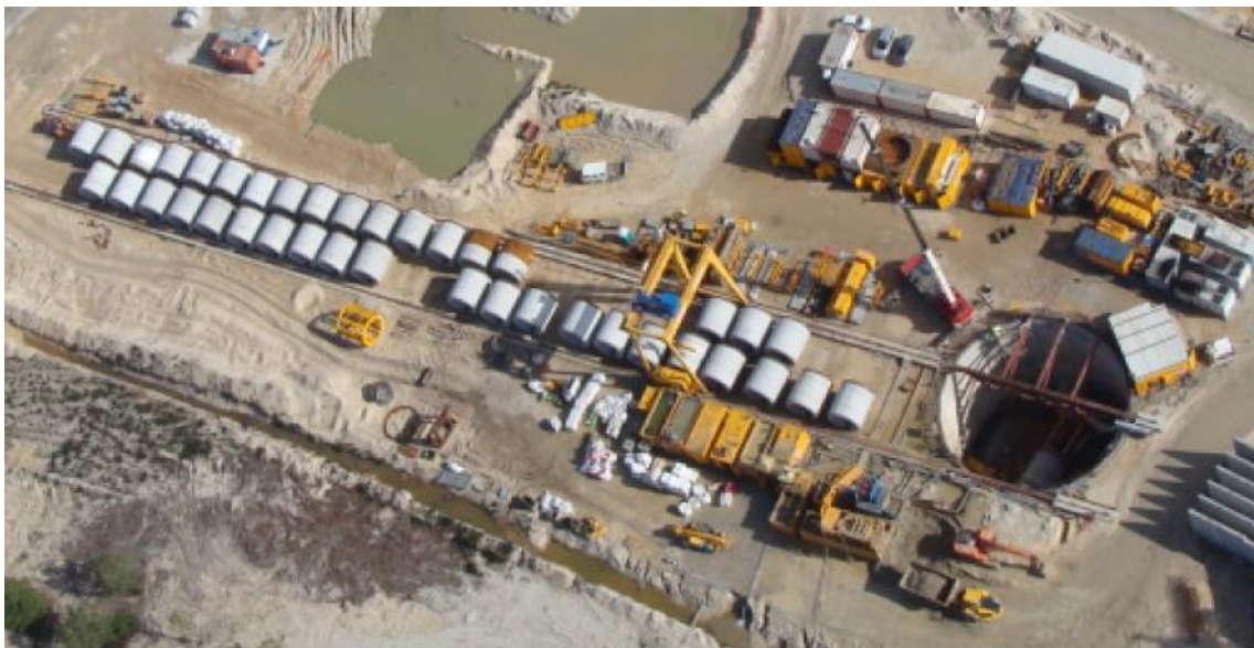
Figura 12-8- Tipico cantiere di costruzione di microtunnel.
