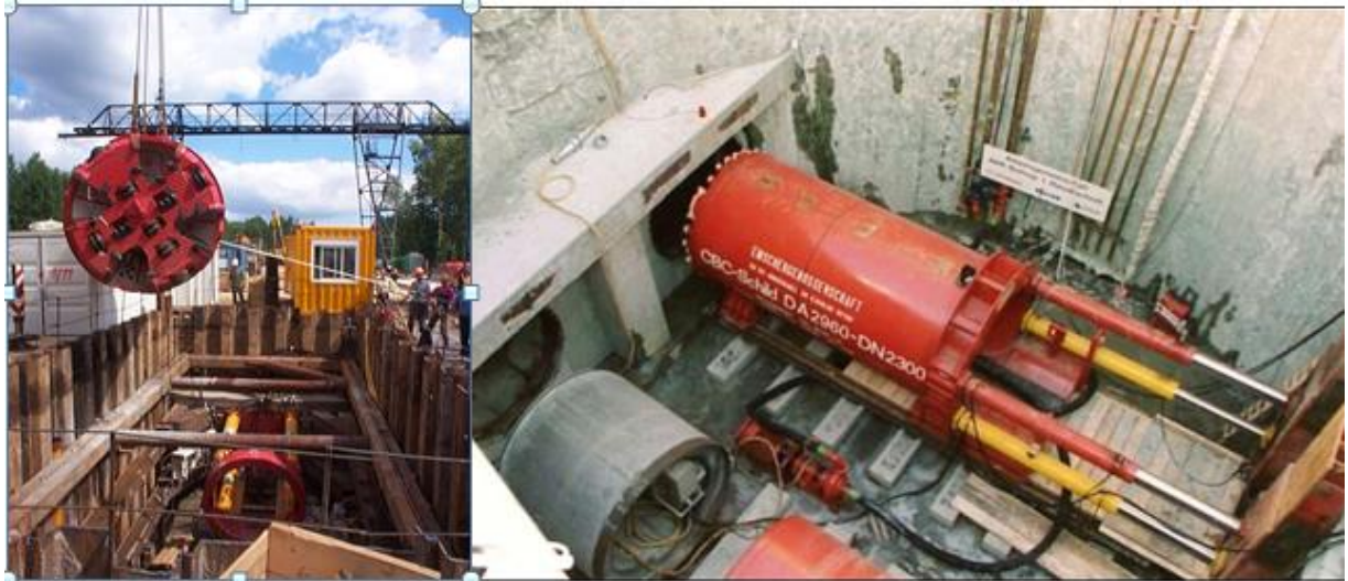
Figura 13-4- Installazione della TBM
