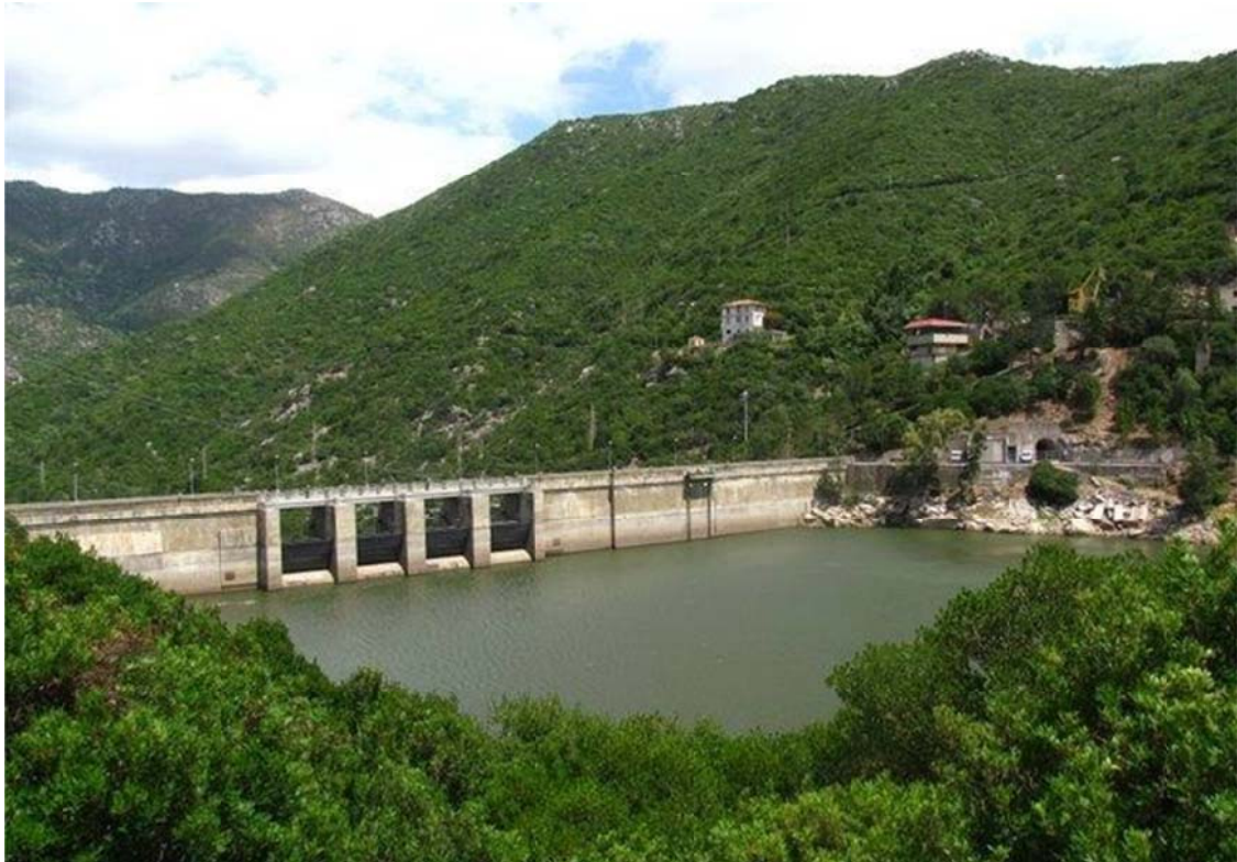
Figura 5 - Diga Muzzone sul fiume Coghinas: vista paramento di monte
