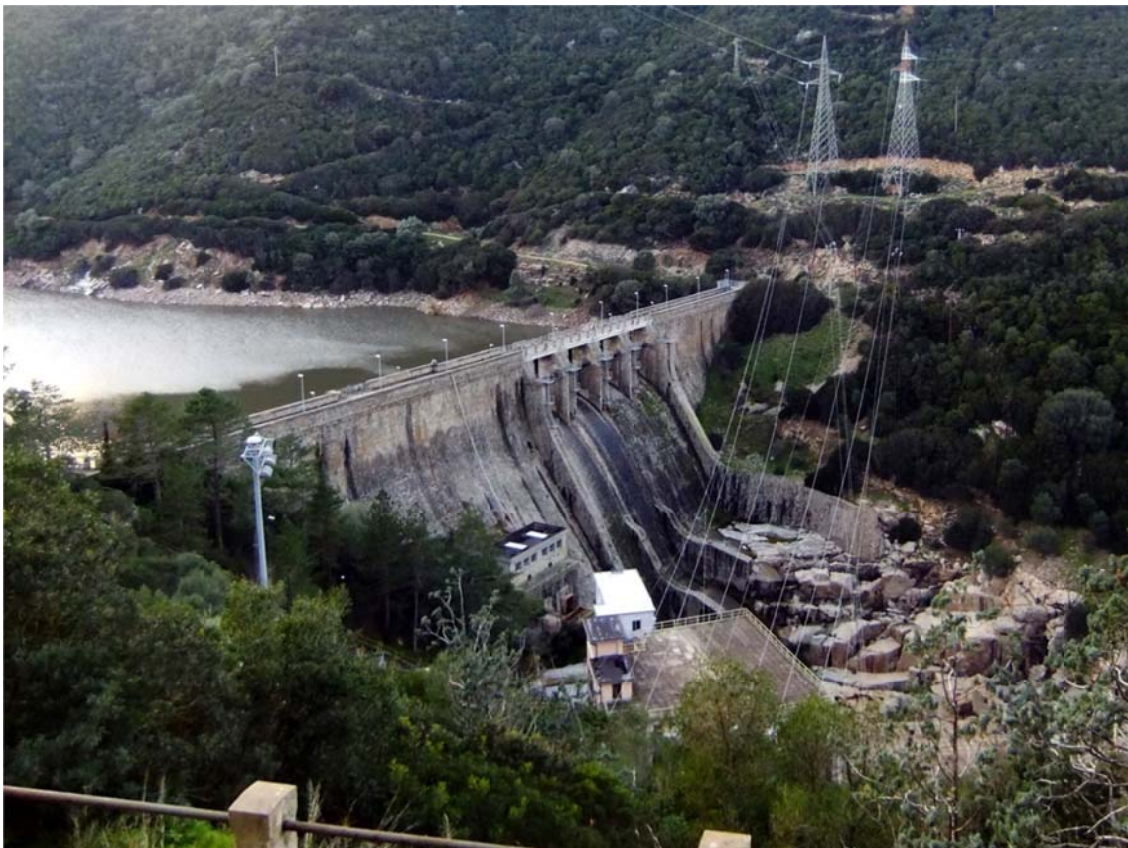
Figura 6 - Diga Muzzone sul fiume Coghinas: vista paramento di valle
