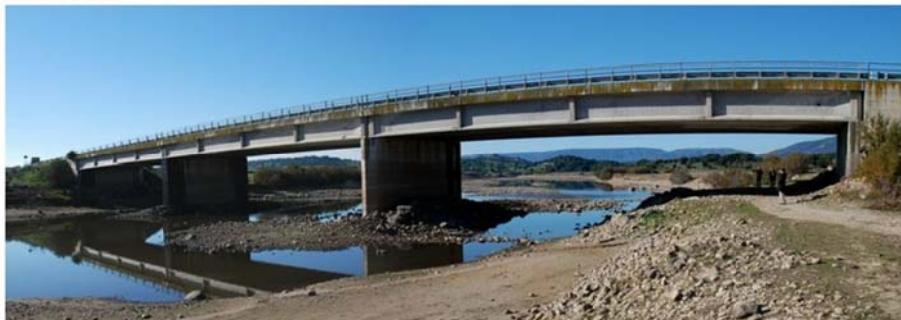
Ponte a tre campate da 33m ciascuna
