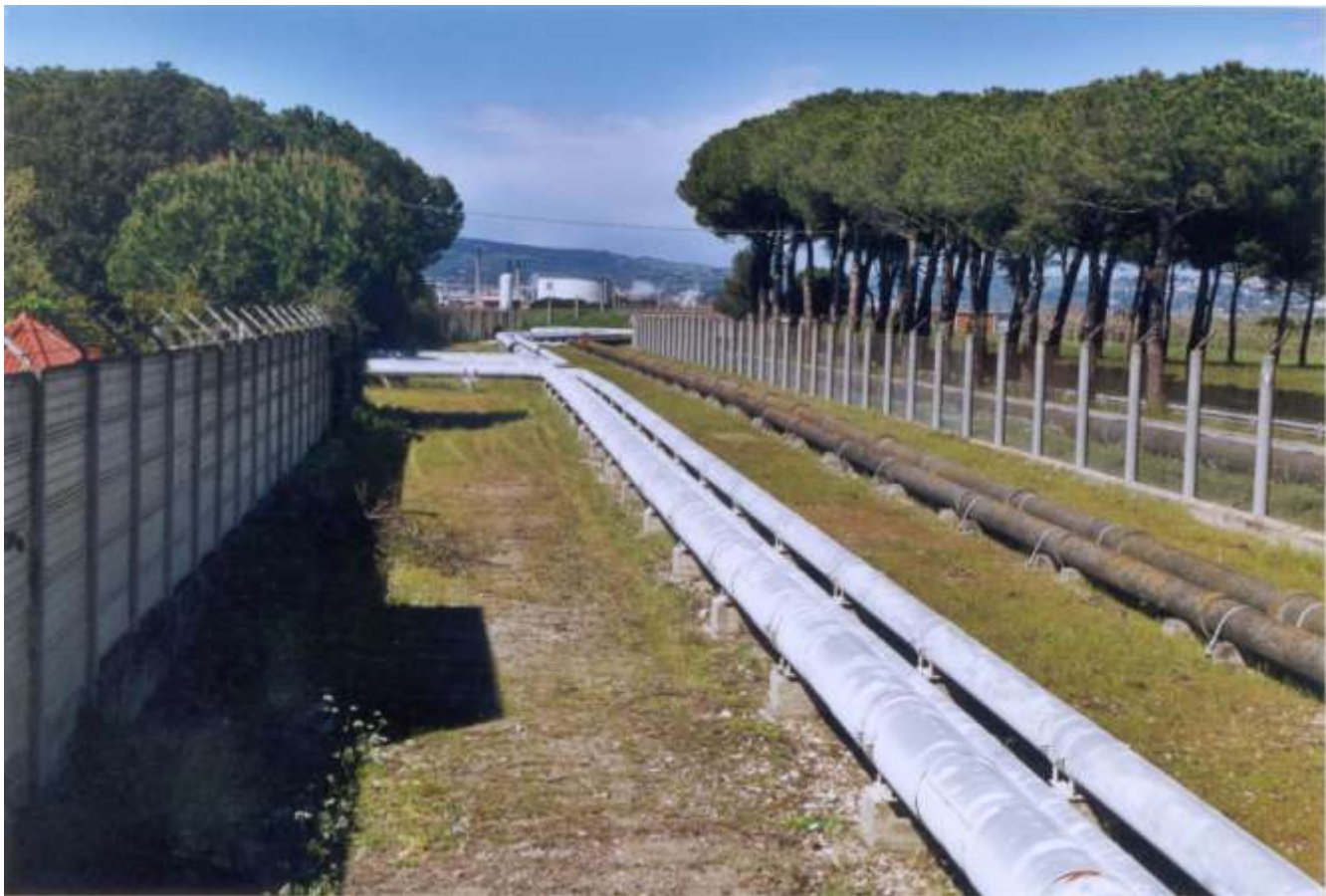
Figura 3.5: Pista Tubi tra il Pontile Solvada e l'area di San Gaetano (Vista verso Monte)
