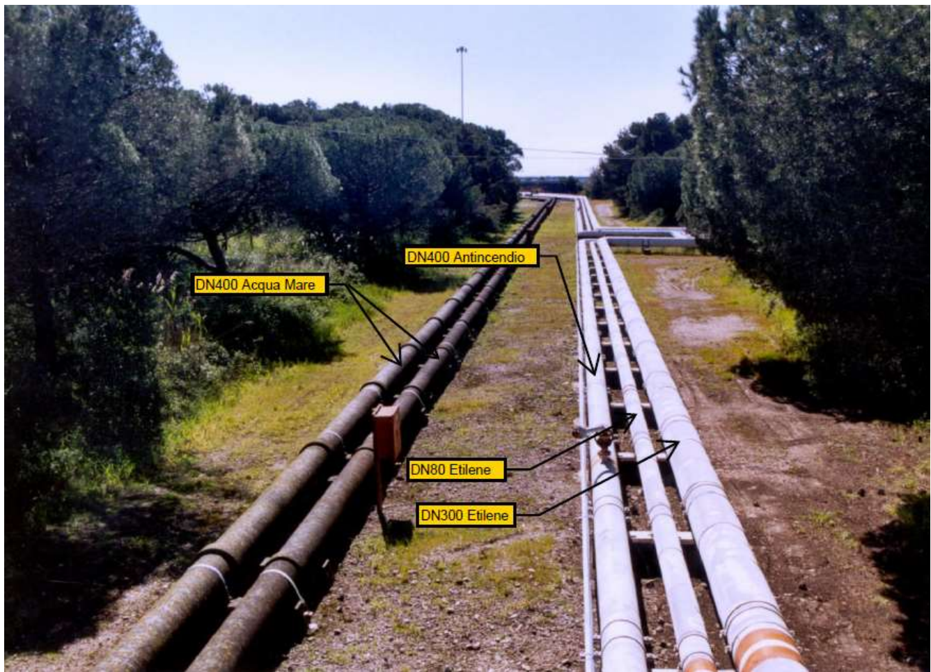
Figura 3.4: Pista Tubi tra il Pontile Solvada e l'Area di San Gaetano (Vista verso Mare)
