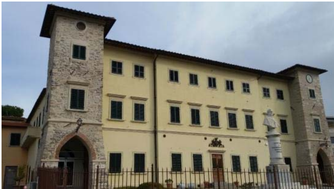
Figura 41: Il Palazzo de Larderel a Larderello
