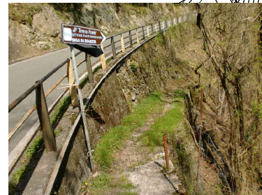
Accesso alla diga dalla strada per Zolezzi
