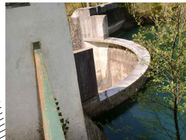
04. Soglia sfiorante della diga vista dalla sponda sinistra verso destra
