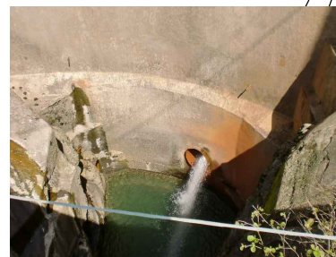
08. Scarico di fondo visto da valle verso monte
