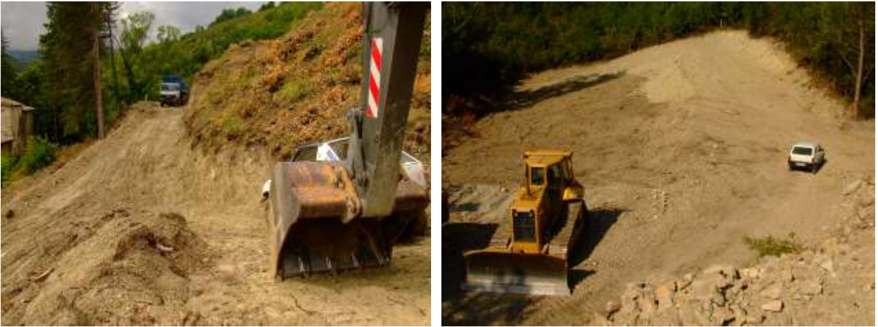
Fig. 5 – Una fase dello sbancamento
