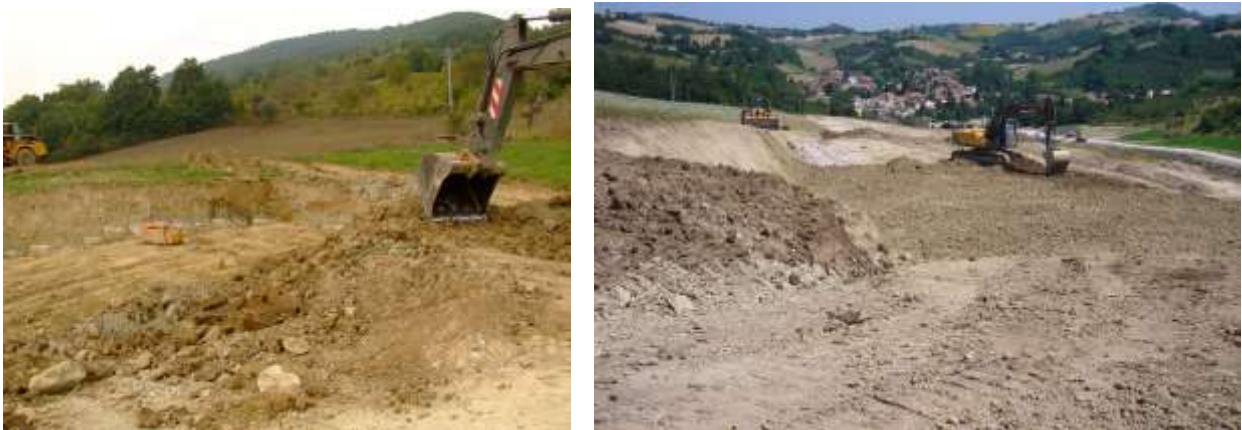
Fig. 2 – Una fase dello sbancamento
