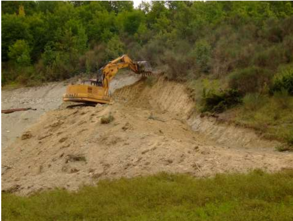
Fig. 3 – Una fase dello sbancamento
