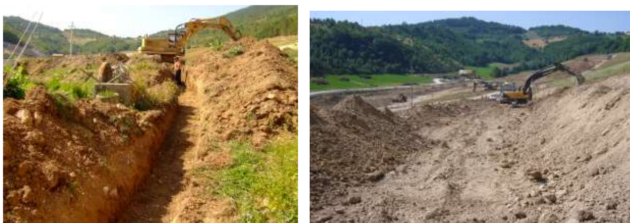
Fig. 1 – Una fase dello sbancamento
