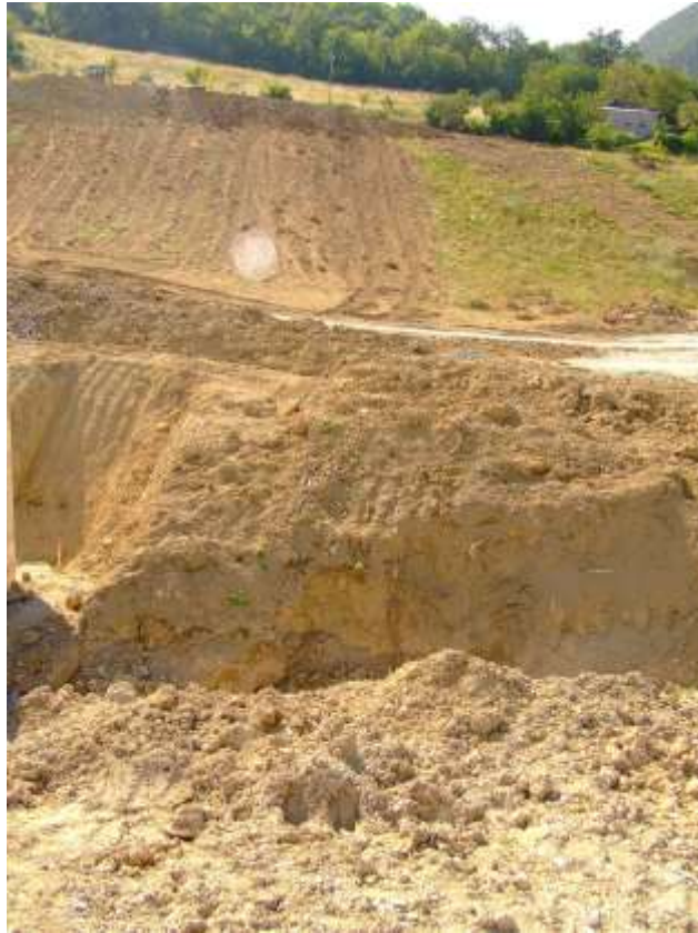
Fig. 1 – Una fase dello sbancamento
