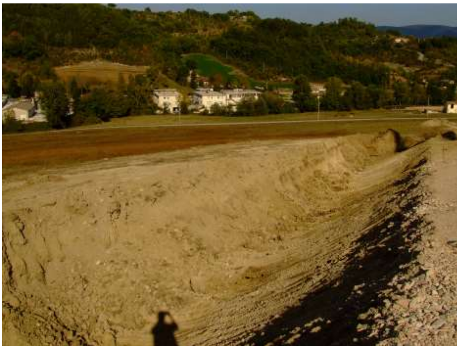
Fig. 4 – Una fase dello sbancamento
