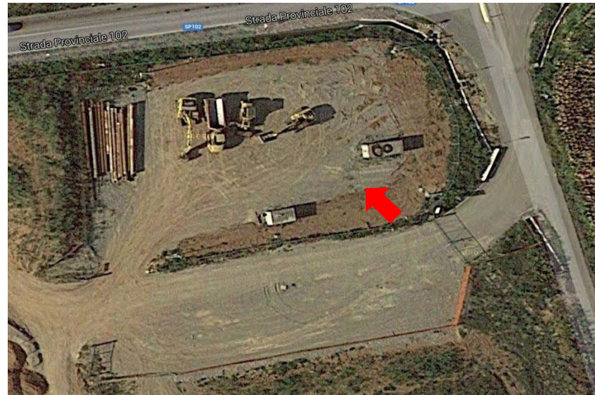
AREA CONTAINER IN FASE REALIZZATIVA
