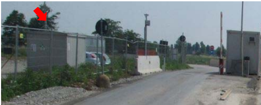
AREA CONTAINER REALIZZATA
