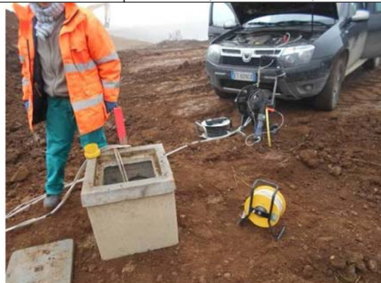
Punto AV-CO-SO1-BG3.2. Spurgo
