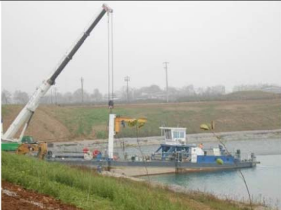
Smontaggio draga e scavo trincee
