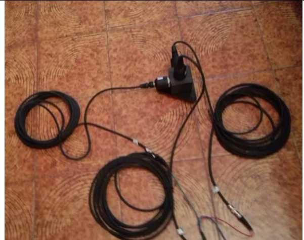
Posizionamento accelerometri monoassiali, 2° piano f.t.
