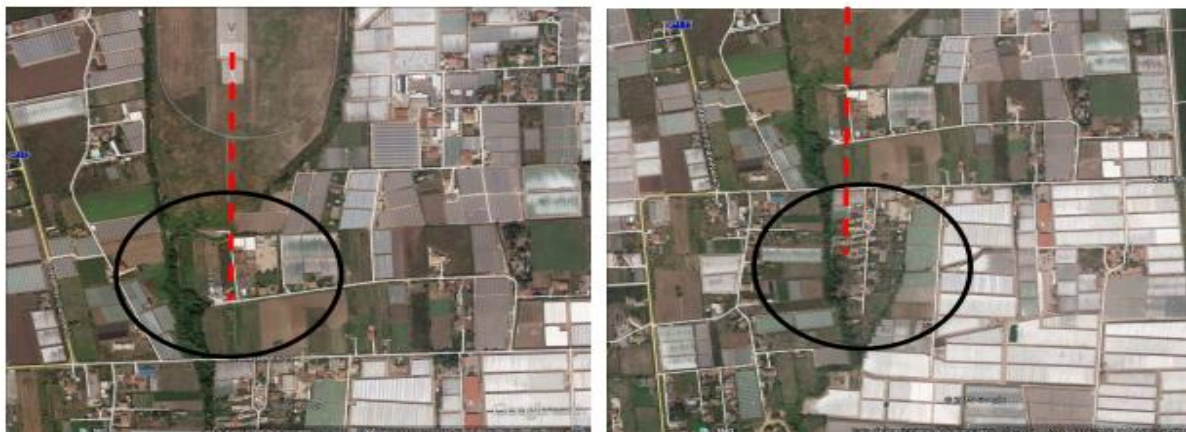
Figura 4-1 Edifici presenti in corrispondenza della testa pista 05.
