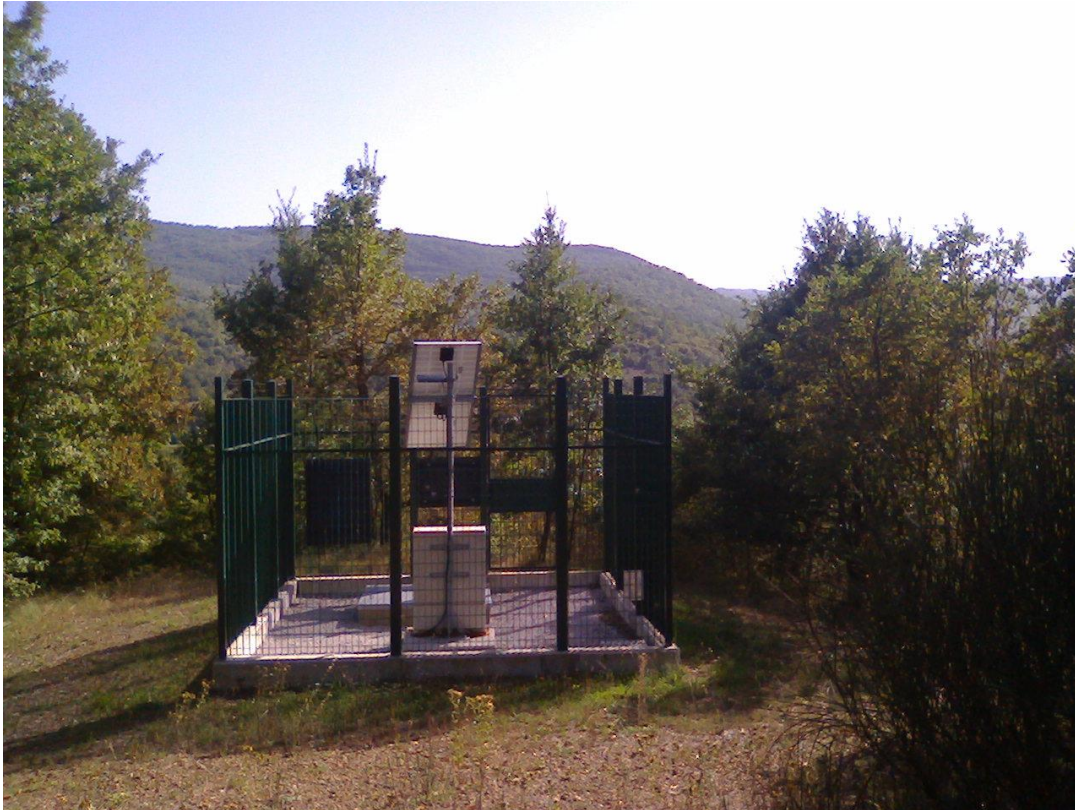
Fig. 30: esempio di stazione microsismica completamente autonoma in zone remote.
