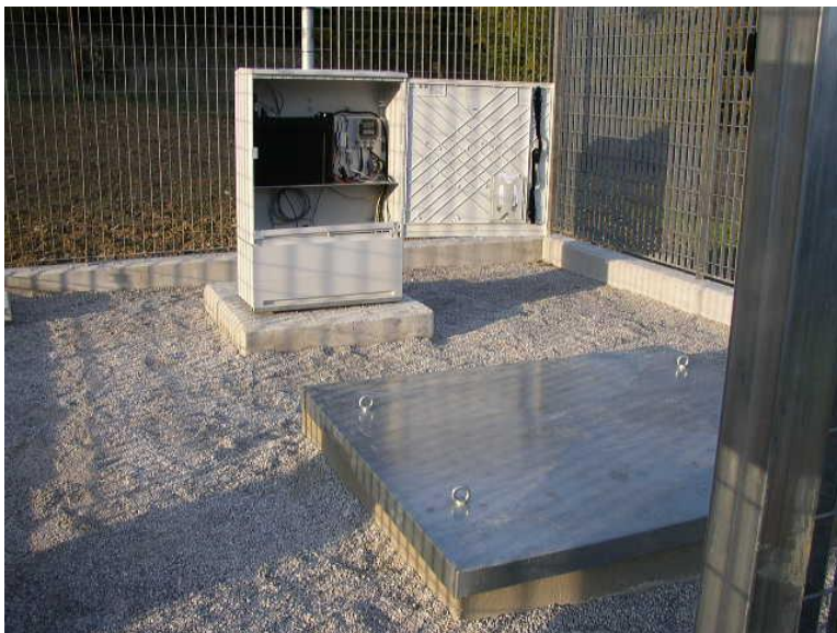
Fig. 31: esempio di alloggiamento della strumentazione nell'armadietto e del sensore all'interno del pozzetto.
