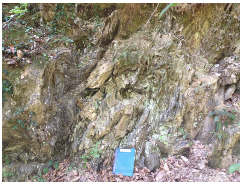
Figura 12. Argilloscisti in sponda destra del Rio Trasta.
