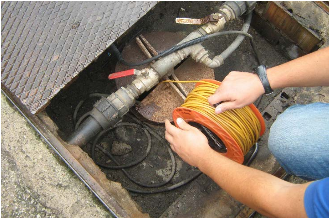
Figura 4: Misurazioni all'interno del pozzo 5
