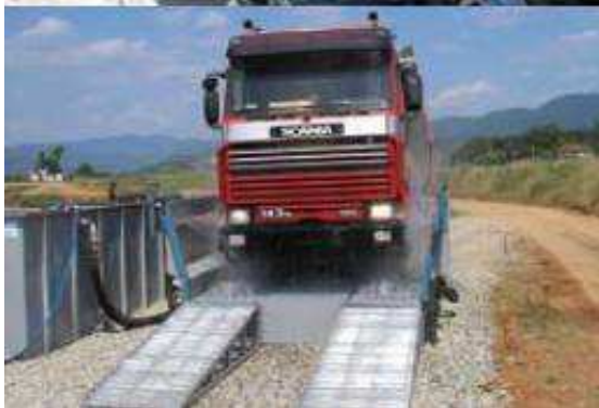
Figura 3-7 - Sistemi per il lavaggio dei pneumatici
