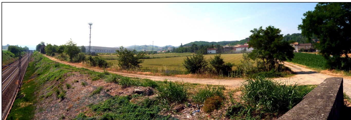
Figura 5-18 Panoramica sull'area di cantiere vista dal cavalcaferrovia esistente
