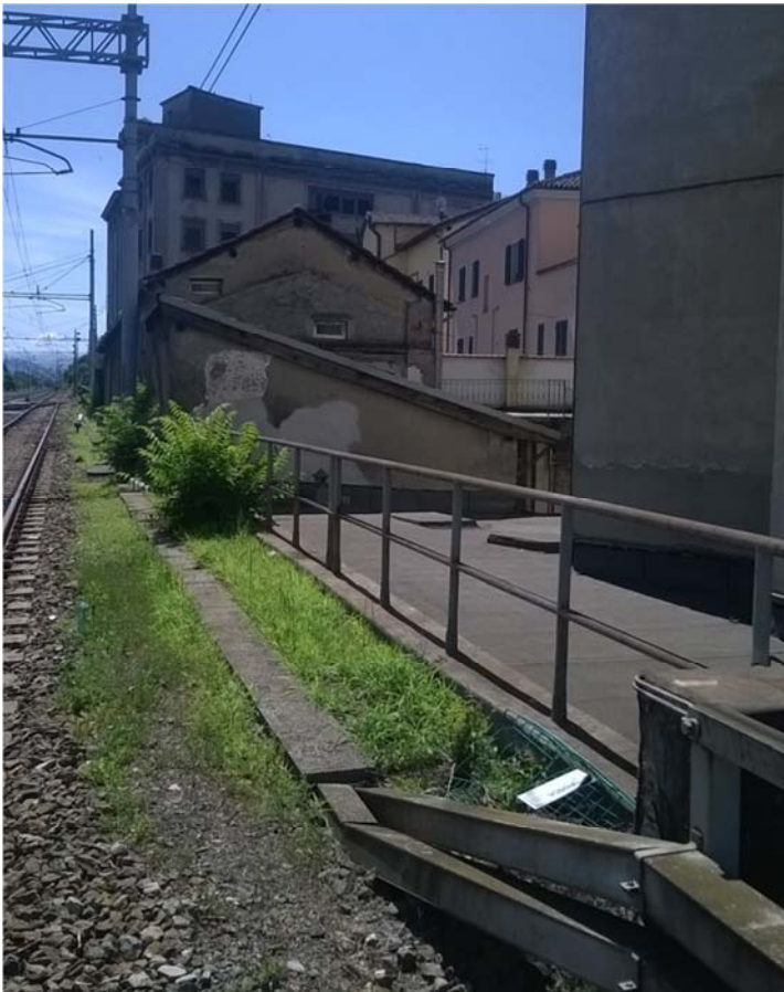
Foto 16 – Vista della copertura piana
