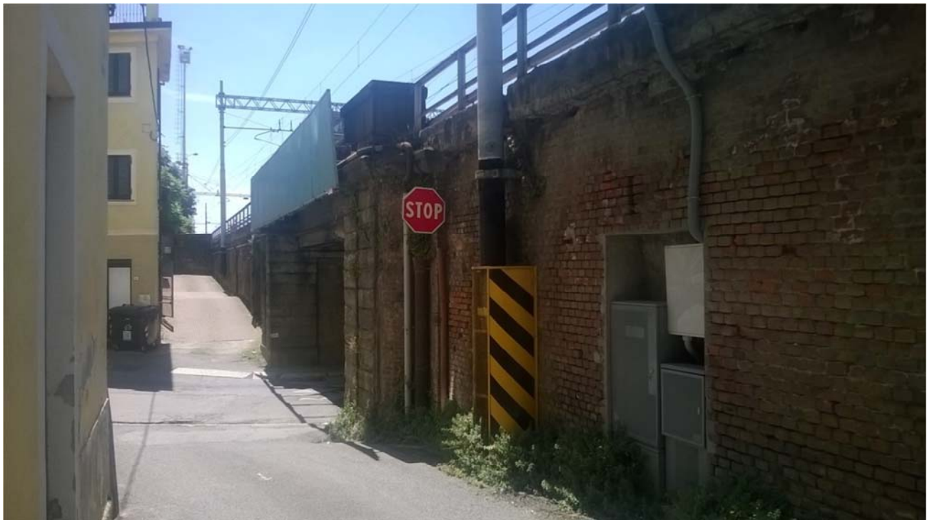
Foto 28 – Vista del sottopasso da livello strada.
