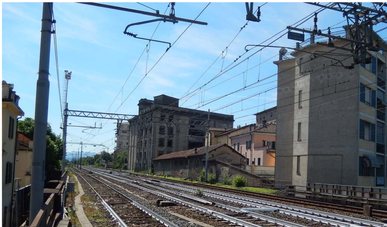
Foto 13 – Vista verso il fabbricato in affaccio sulla ferrovia.
