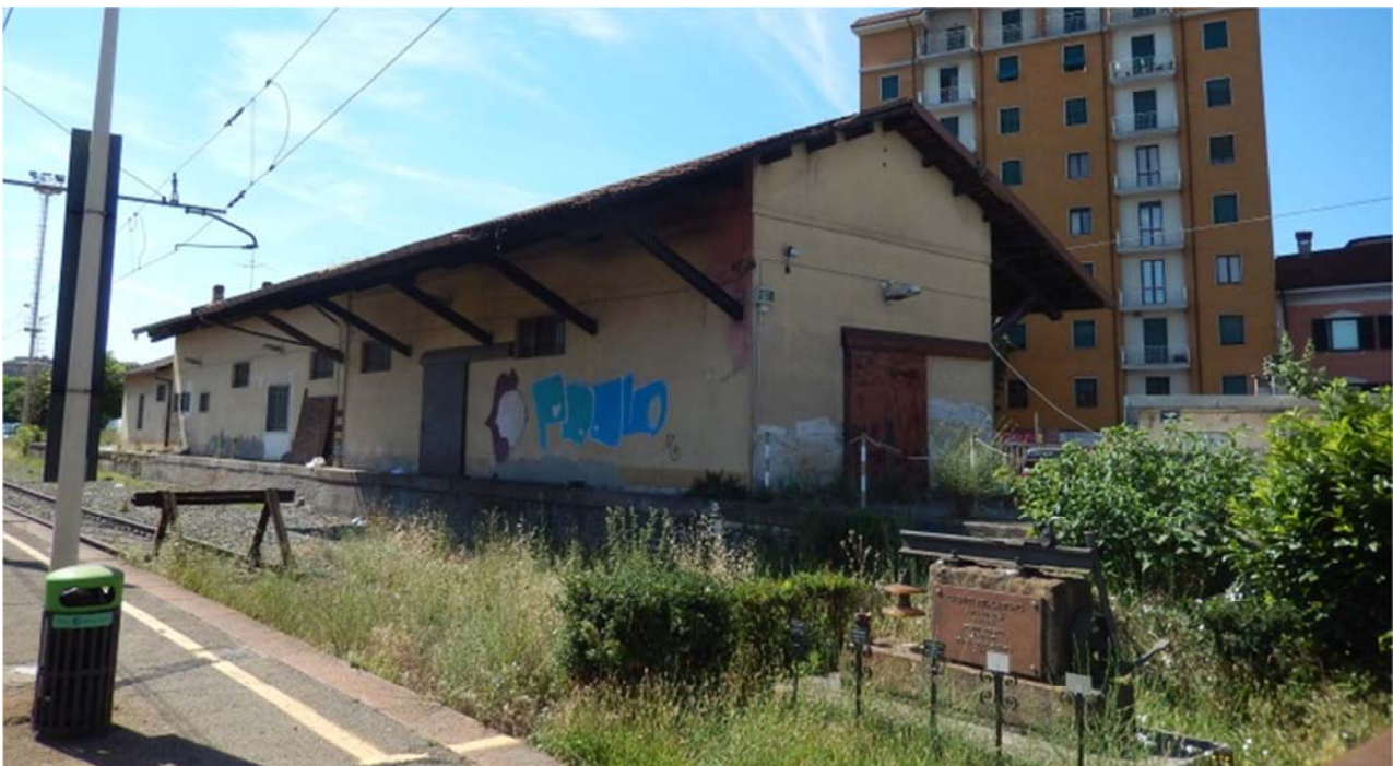
Foto 33 – Il fabbricato tecnico presso la stazione di Novi Ligure.
