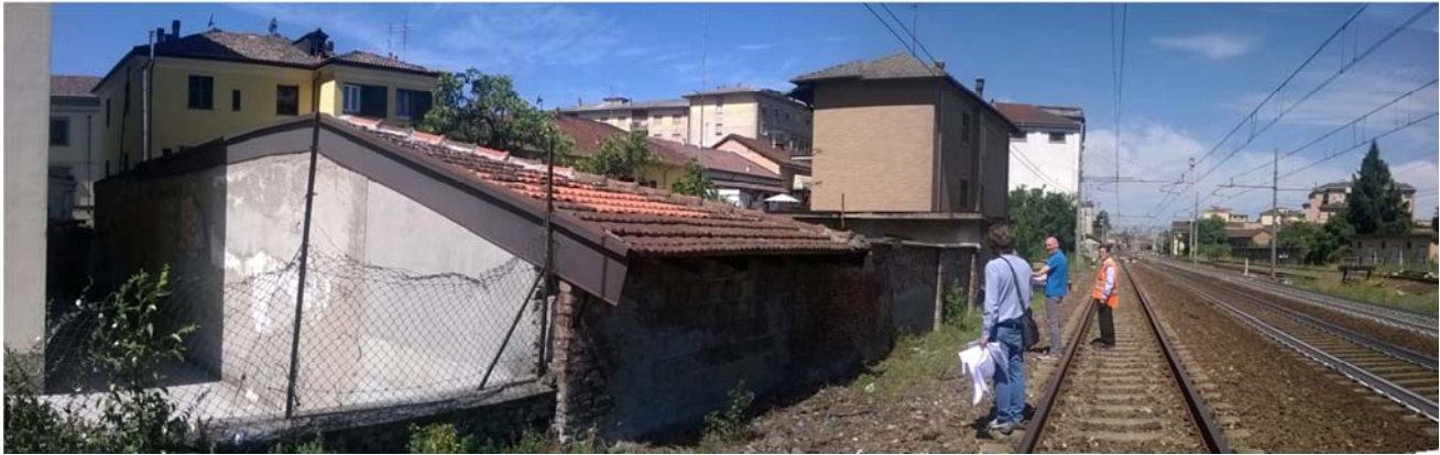
Foto 8 – Panoramica del fabbricato sul prospetto laterale.
