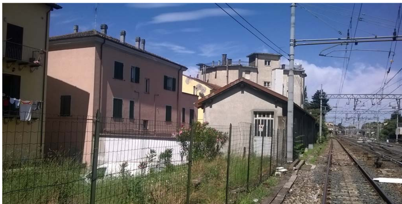
Foto 14 – Vista laterale del fabbricato. Si nota la mancanza di spazio utile per l'inserimento delle barriere.
