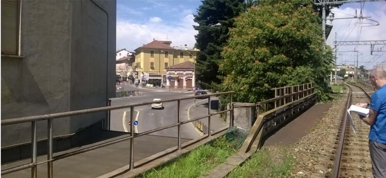
Foto 15 – Vista della copertura piana verso il sottopasso ferroviario.
