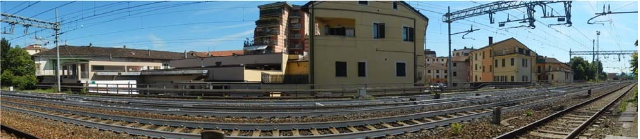
Foto 24 – Panoramica dell'area interessata dall'intervento di integrazione dal piano dei binari.
