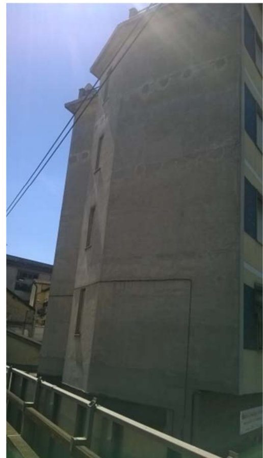
Foto 17 – Facciata dell'edificio residenziale attestante la ferrovia.
