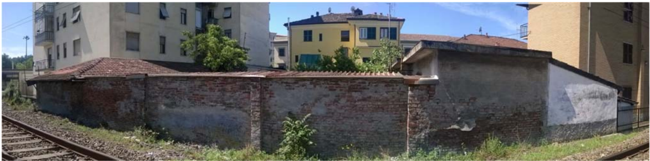
Foto 9 – Panoramica del basso fabbricato sul prospetto affacciante i binari.
