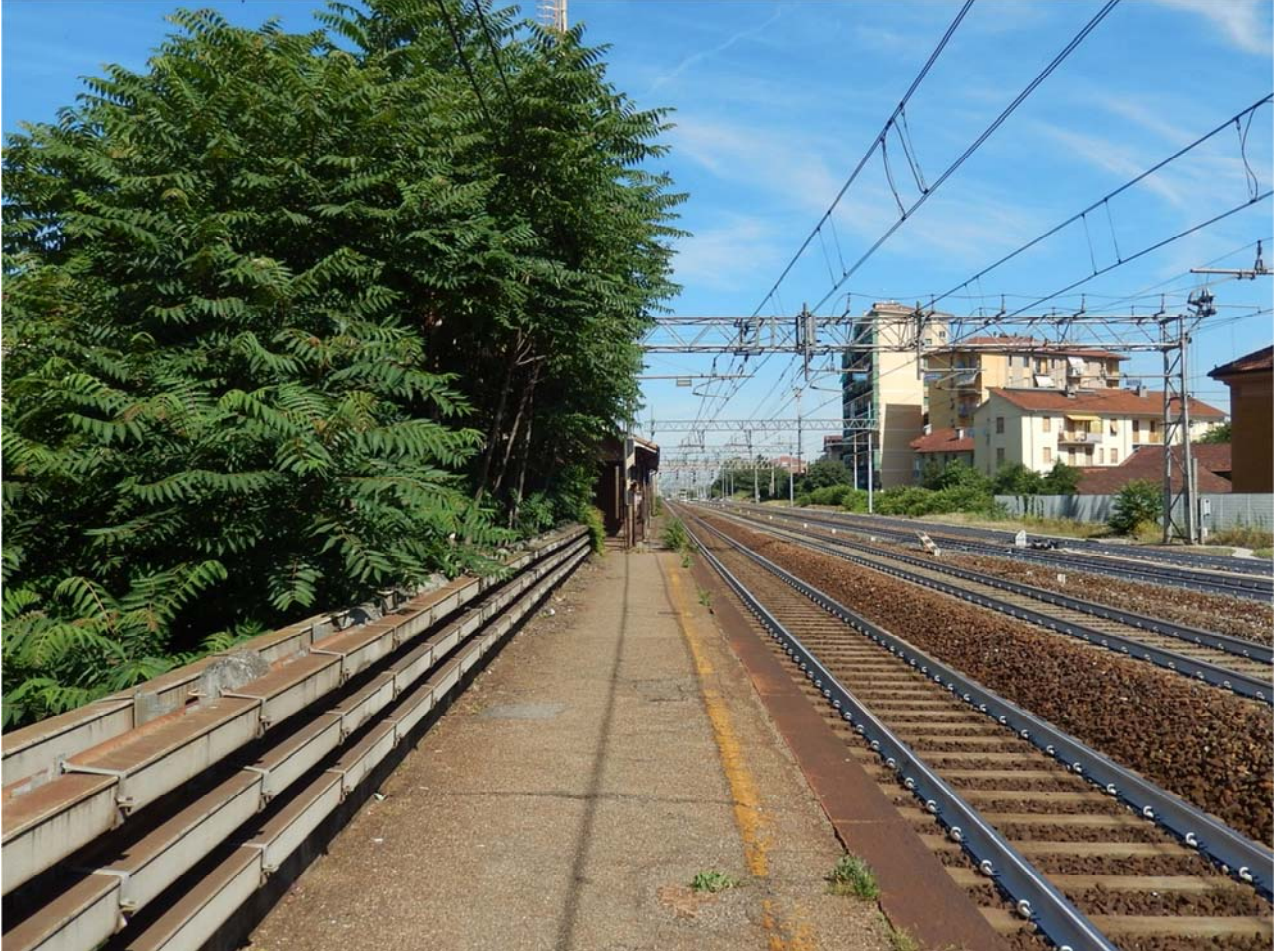
Foto 38 – Vista del lungolinea ferroviario. Si nota al centro il fabbricato affacciante i binari causa dell'interruzione.
