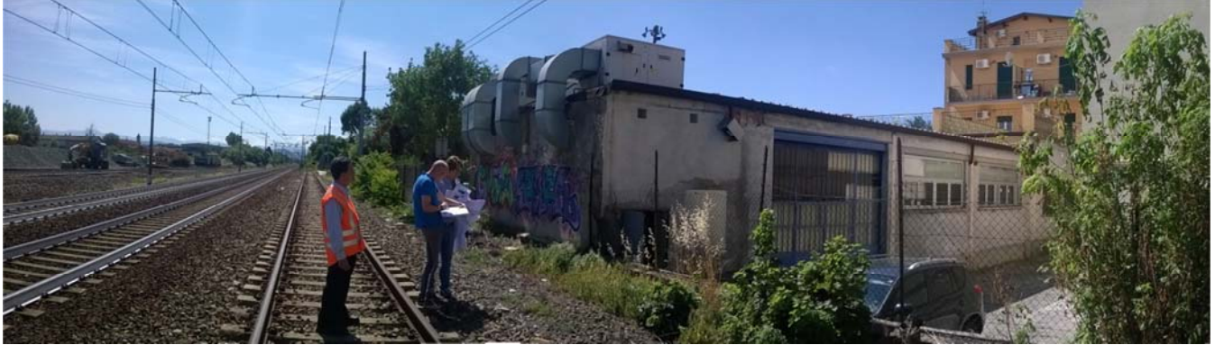
Foto 6 – Panoramica del basso fabbricato attestante i binari che impedisce l'integrazione delle barriere.
