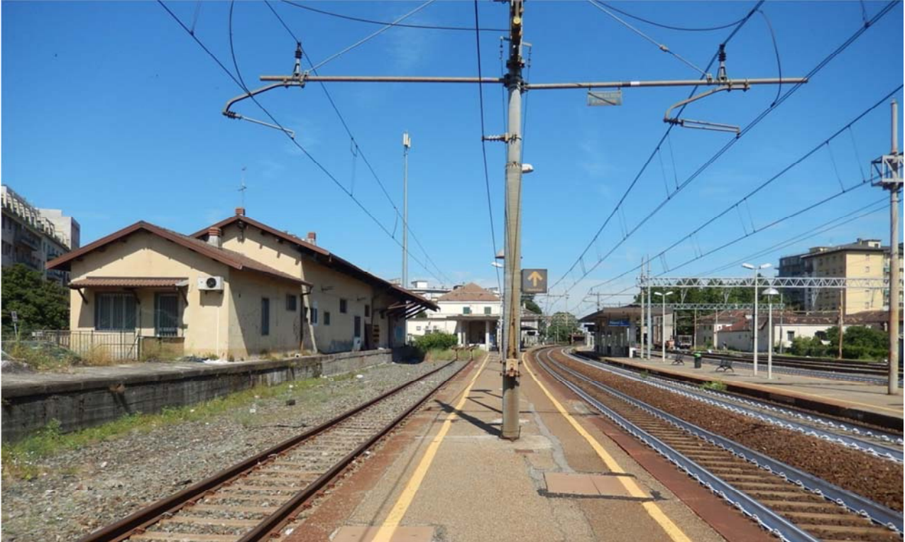
Foto 32 – Vista del marciapiede di stazione.
