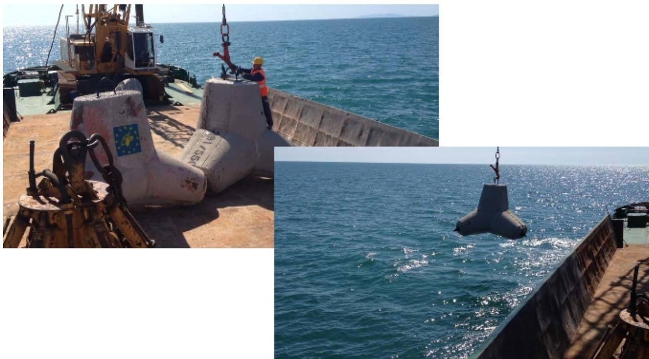
Fig. 52 Esempio di tetrapode installato durante il progetto Life Poseidone
