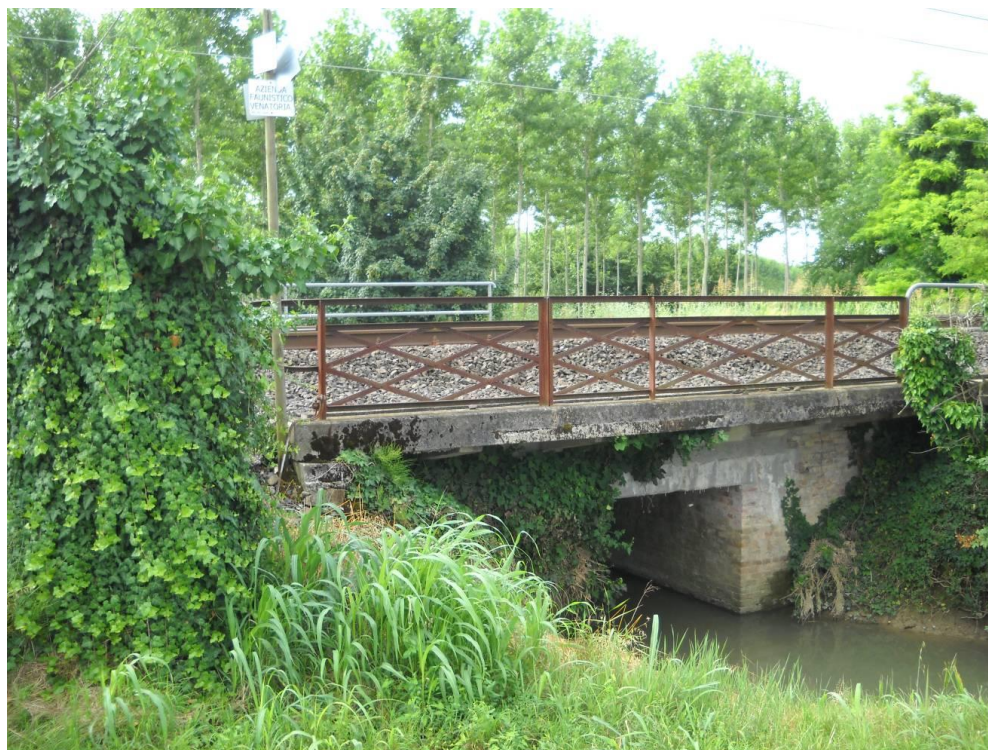
Figura 3-12: scolo San Giovanni, recapito finale di parte delle acque di piattaforma ferroviaria
