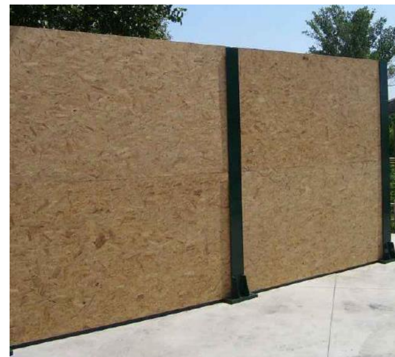
Figura 6-2: recinzione di cantiere con pannelli tipo OSB
