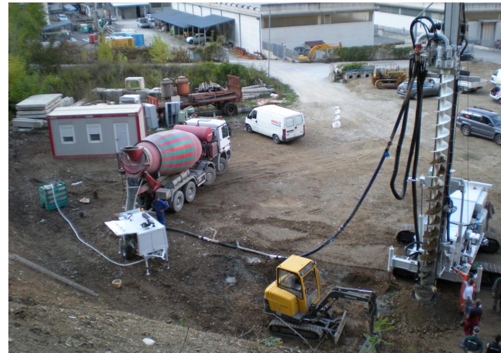
Figura 3-7: organizzazione di un cantiere con tecnologia CFA
