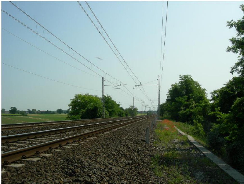
Figura 3-4: rilevato ferroviario allo stato attuale
