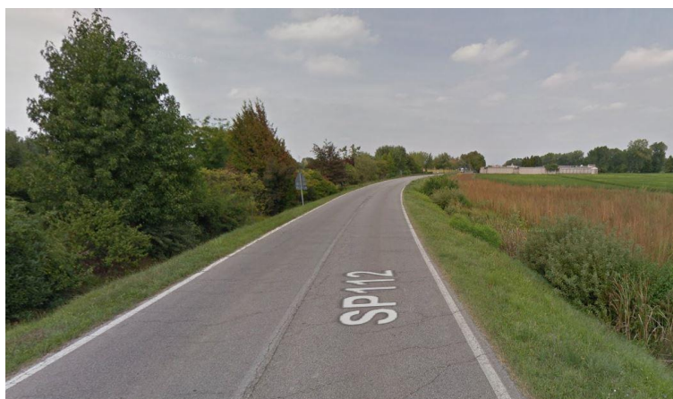
Figura 6-1 Vista della sede stradale della S.P.112
