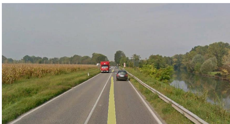
Figura 6-2 Vista della sede stradale della S.P. 64
