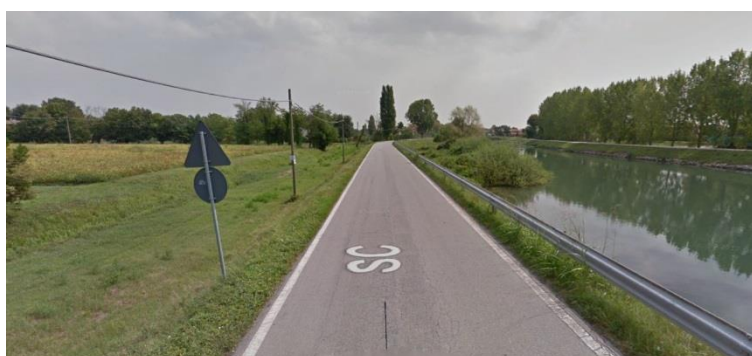
Figura 6-3 Vista della sede stradale di via Principe non percorribile dai mezzi pesanti
