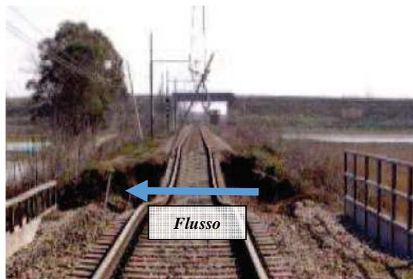
Figura9 – Evento 4-5 marzo 2005 – Collasso del rilevato ferroviario a fianco del tombino Olivella 2
