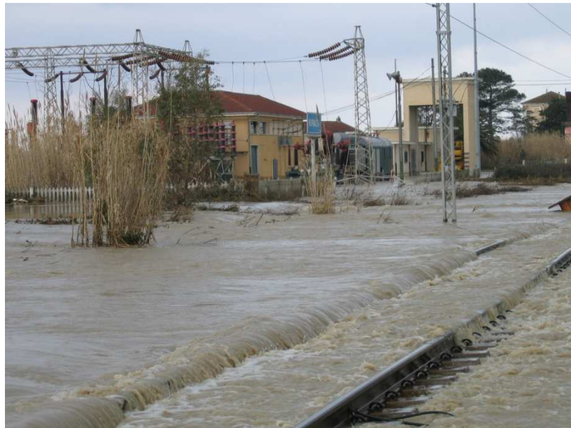
Figura 1. La ex stazione di Ripalta durante l'esondazione del Fortore. In basso a destra il binario sormontato dall'acqua
