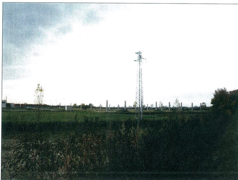
Vista dell'area destinata al cantiere operativo.
