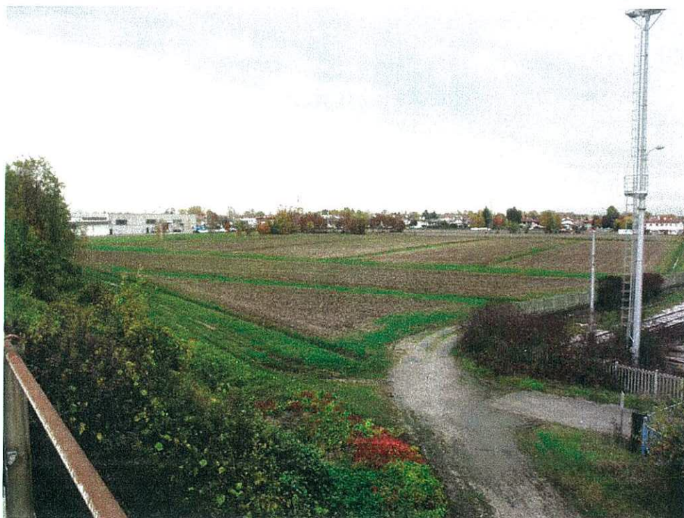
Vista dell'area destinata al cantiere di armamento dal cavalcavia della Strada Regionale n. 53 Postumia Cittadella - Portogruaro.
