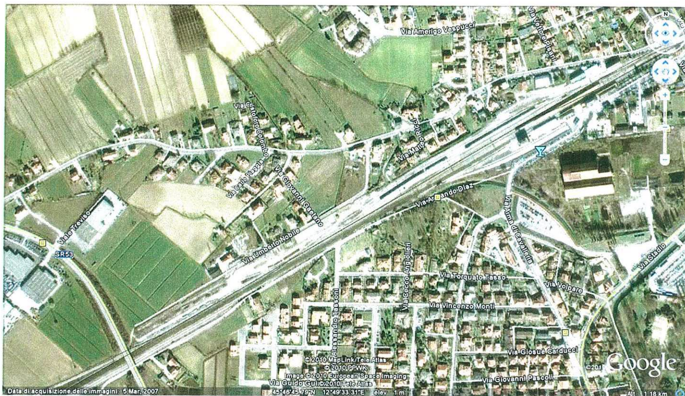
Vista aerea dell'area destinata al cantiere operativo (Ortofoto da Google Earth).
