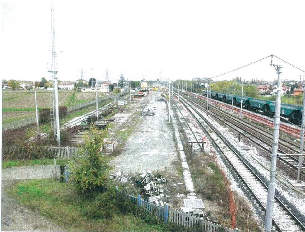
Vista dell'area destinata al cantiere di armamento dal cavalcavia della Strada Regionale n. 53 Postumia Cittadella - Portogruaro.
