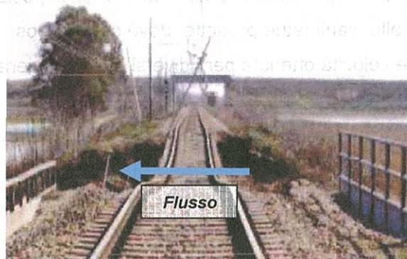
Figura 22 – Evento 4-5 marzo 2005 – Collasso del rilevato ferroviario a fianco del tombino Olivella 2
