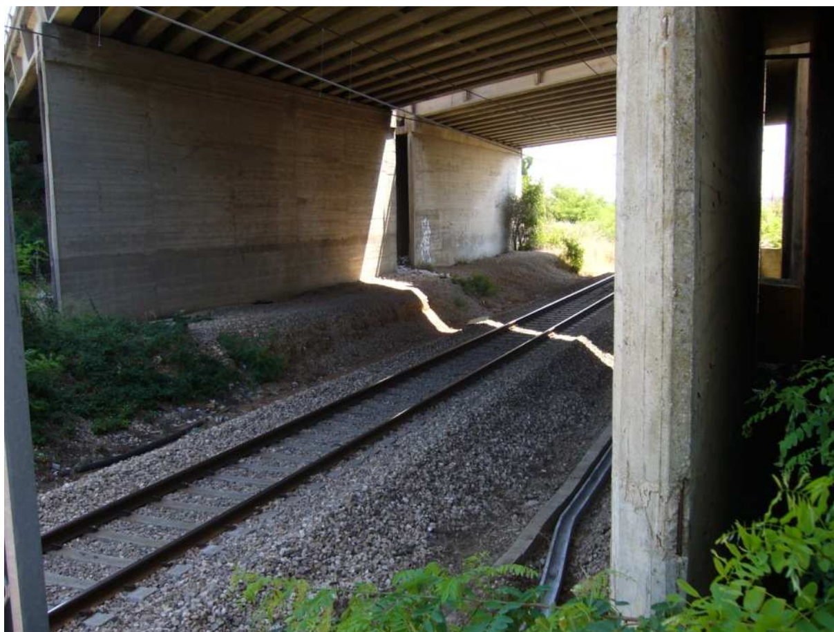
Foto 1 CVF autostrada A14
