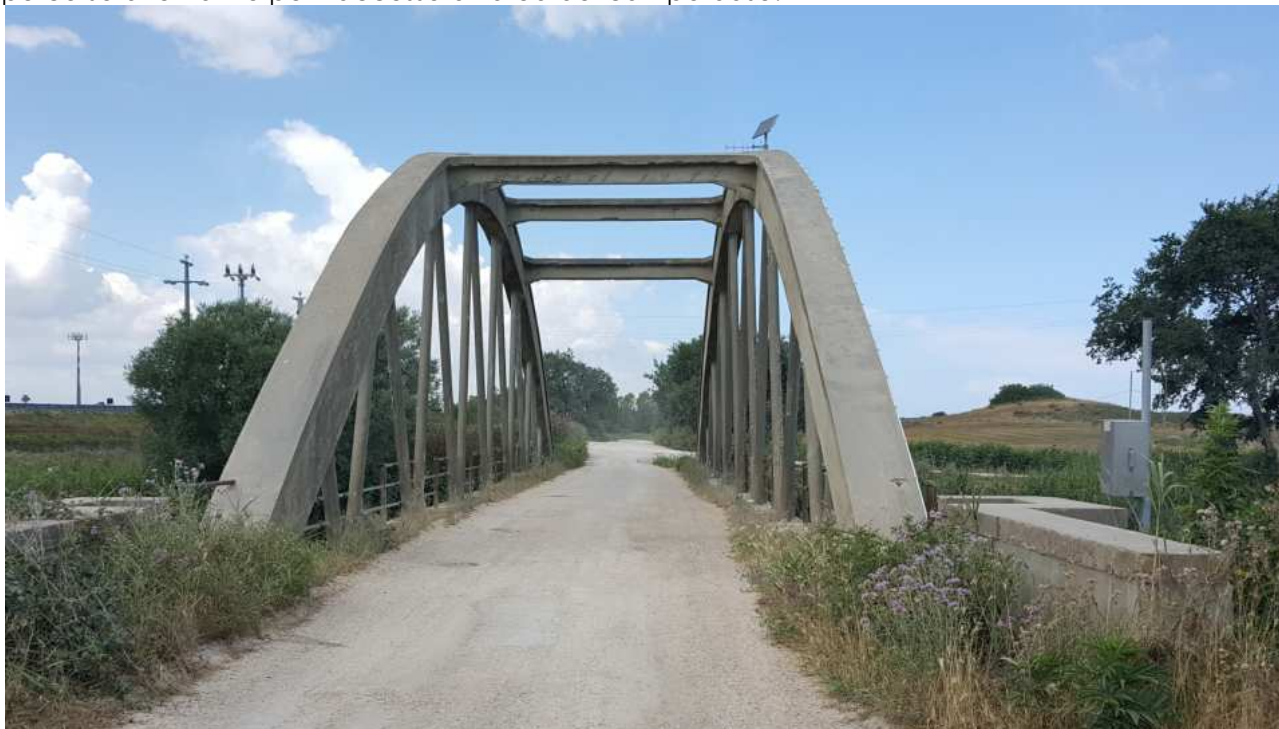
Ponte di accesso all'area di cantiere
