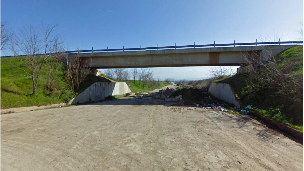
Foto 2 Strada Pede sub appenninica dalla SS 16 verso la SP 37
