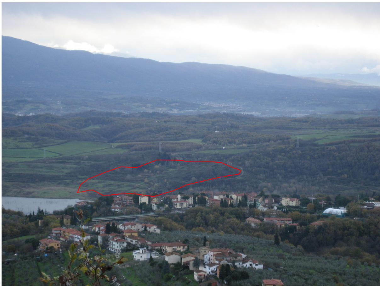
Documentazione fotografica dell'area in frana attiva posta a Sud della zona d'intervento
