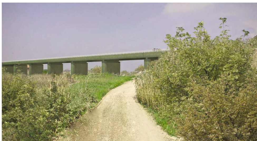
Figura 7 – Vista viadotto Ripalta trattamento in cromie di verde
