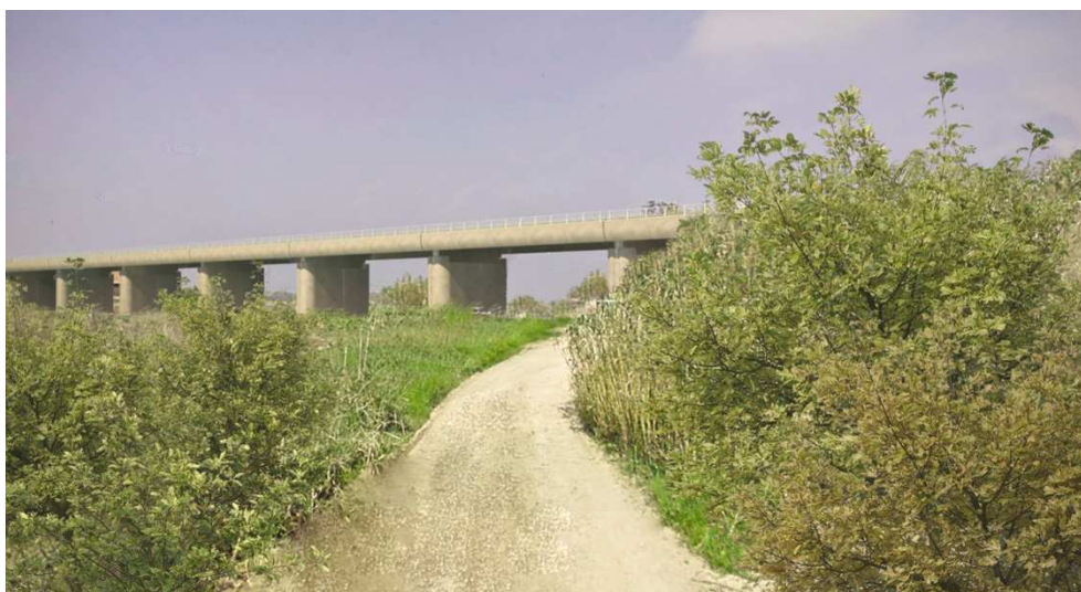
Figura 5 – Vista viadotto Ripalta
