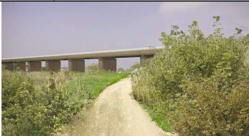
Figura 6 – Vista viadotto Ripalta trattamento in cromie di rosso
