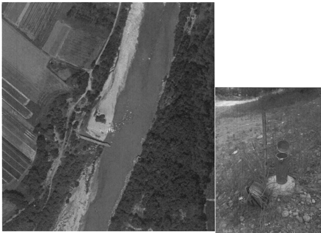
Fig. 3 – a) Ubicazione sondaggio (S1) attrezzato a piezometro. b) Particolare dell'opera.
