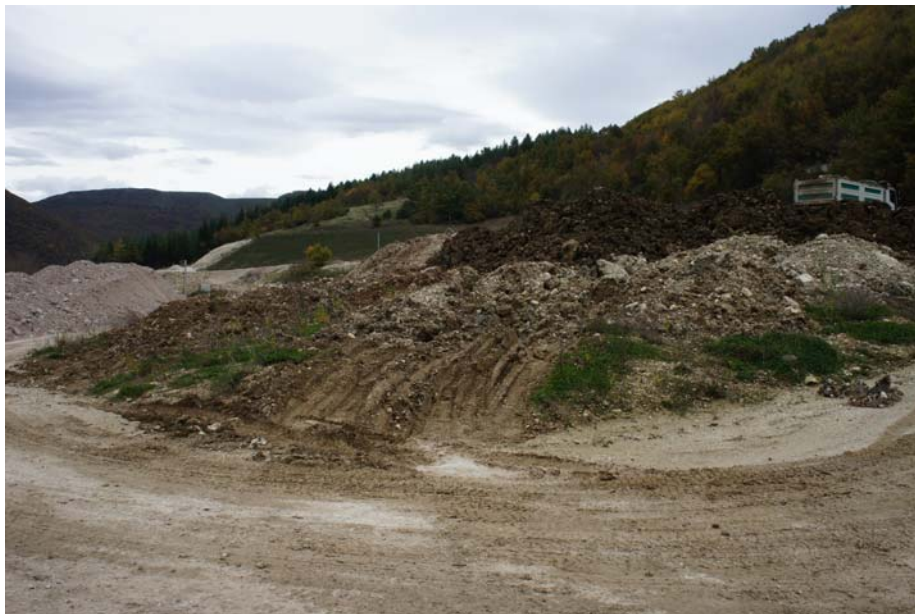
Figura 6.f - Immagine dell'area in fase di cantiere
