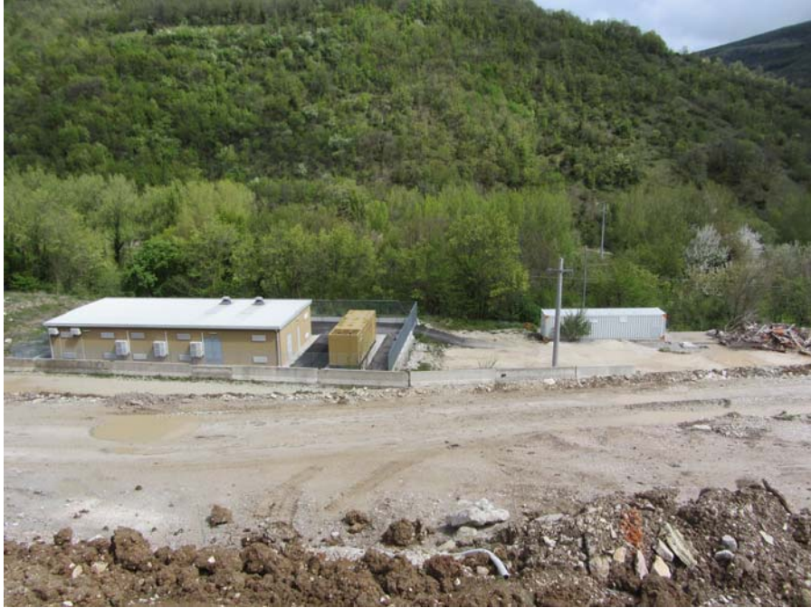
Figura 6.c - Immagine dell'area in fase di cantiere
