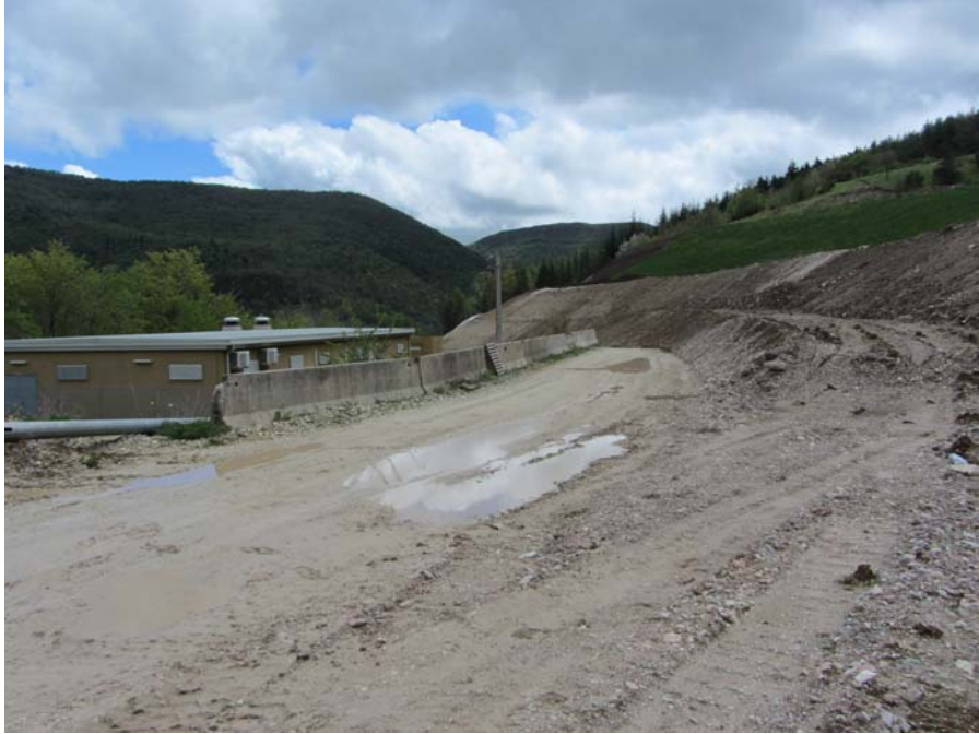
Figura 6.e - Immagine dell'area in fase di cantiere
