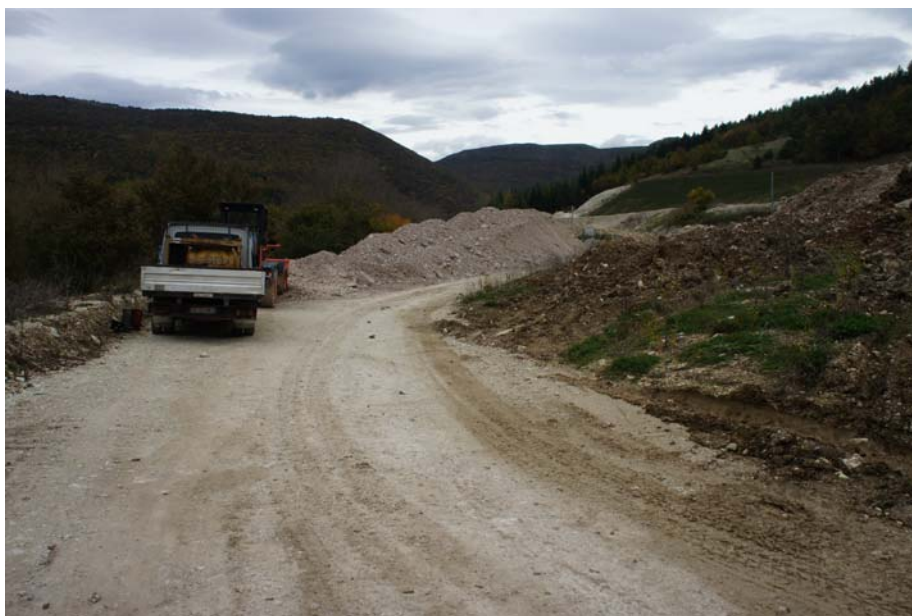
Figura 6.g - Immagine dell'area in fase di cantiere
