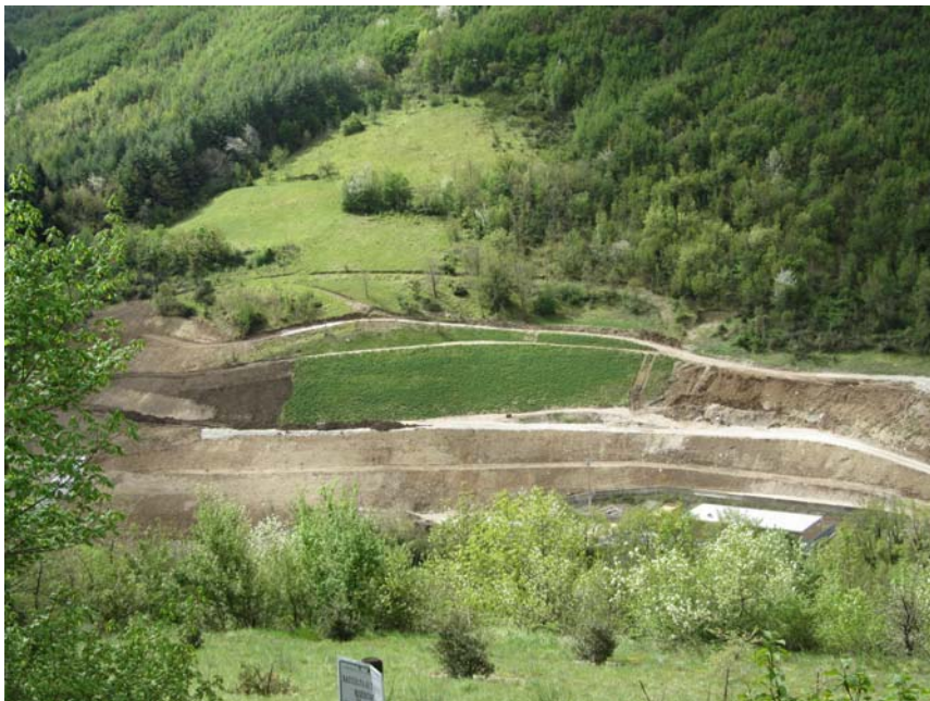
Figura 6.b - Immagine dell'area in fase di cantiere
