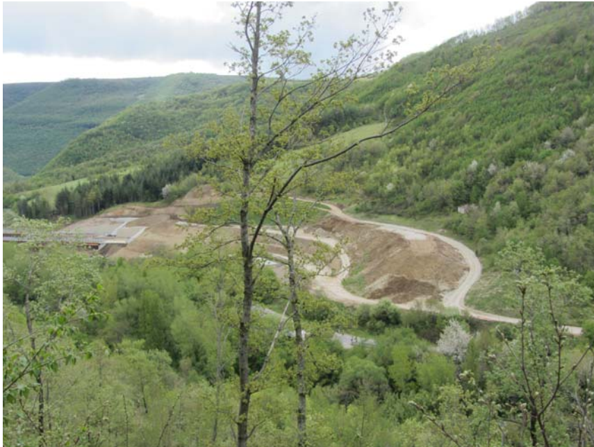
Figura 6.a - Immagine dell'area in fase di cantiere
