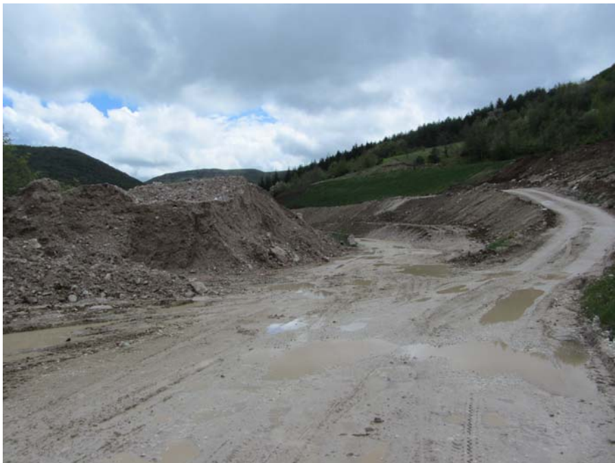
Figura 6.d - Immagine dell'area in fase di cantiere
