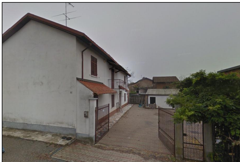
Figura 4-50 Edifici residenziali a est del cantiere, ricettori 5
