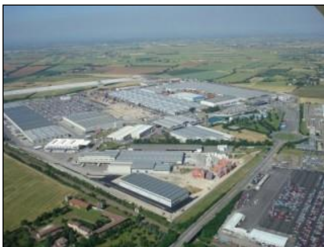
Figura 4-58 Interporto di Rivalta, prossimo all'area di cantiere CA03
