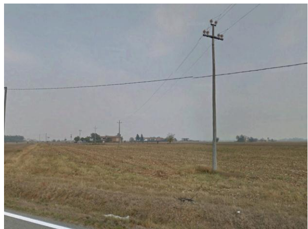
Figura 4-62 Vista in direzione dell'area di cantiere CA3 dalla SP 149
